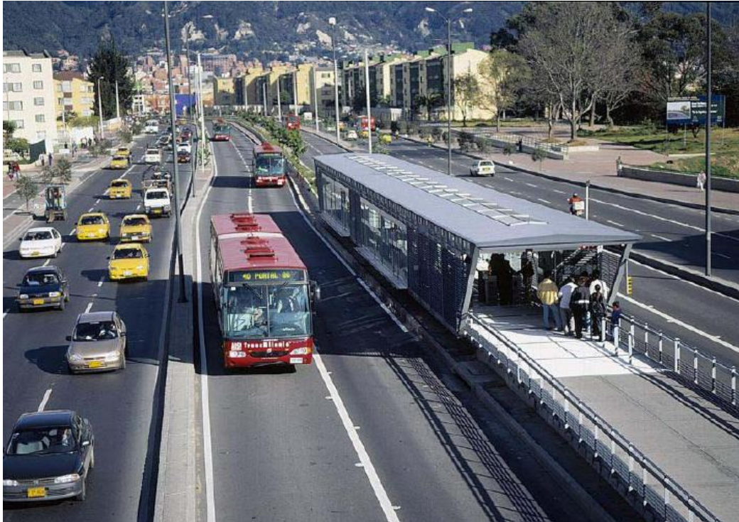
Figura 5 – Corredor do sistema TransMilenio em Bogotá (foto por cortesia de Volvo Bus Corporation para o Manual de BRT – p. 11)
