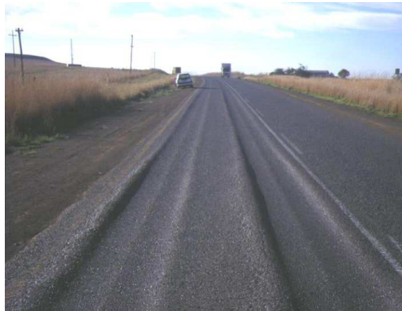
Figura 1 - Deformação permanente em trilha de roda
