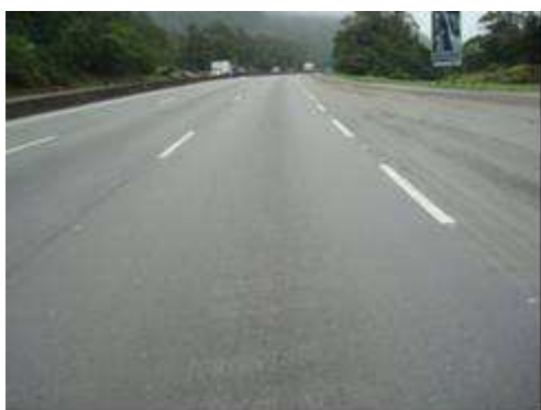
Figura 62 - Pista-teste construída na 3ª. faixa de tráfego sentido ascendente
