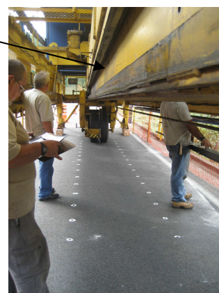
Figura 58 - Barra de reação e cabo de aço
