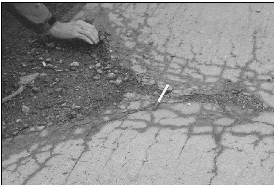
Figura 10 - deterioração em junta transversal da placa de concreto
