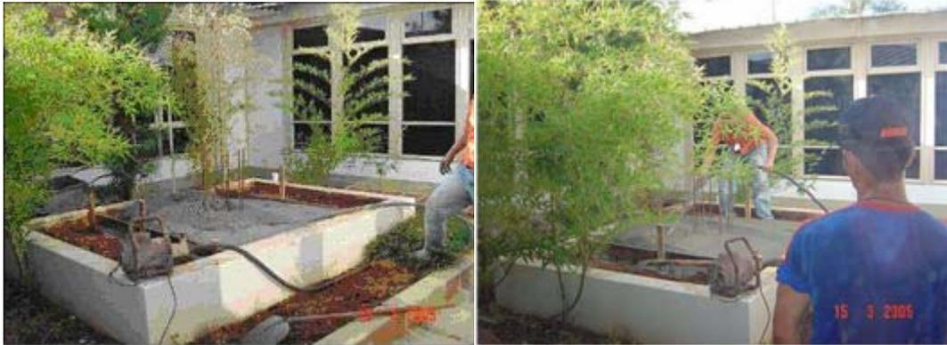
Figura 6.7 – Concretagem da base do Pilar da estação de monitoramento contínuo ITAI.
