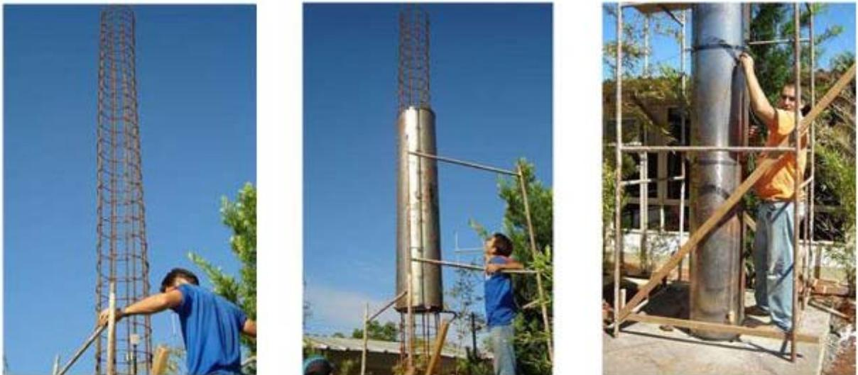
Figura 6.8 – Colocação da armadura e fôrma no pilar, e verificação do prumo.
