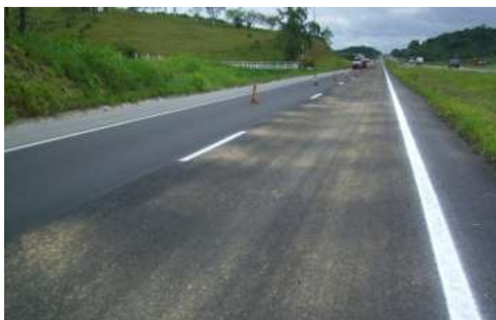
Figura 60 – Salgamento do pavimento reciclado antes da abertura ao tráfego
