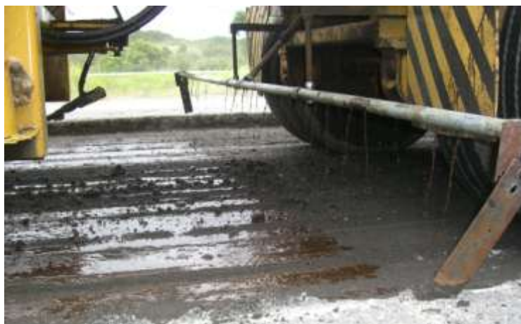
Figura 56 – Espargidores para realização de pintura de ligação
