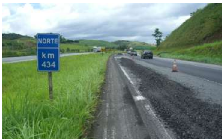
Figura 50 – Faixa junto ao canteiro central, com fresagem previa e execução concomitante com faixa I de rolamento
