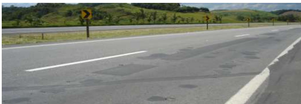
Figura 43 – Segmento reciclado com adição de cal – diversas intervenções após 3 meses da execução da camada de revestimento em microrrevestimento
