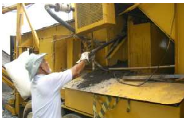
Figura 5 – Retirada de agregado fresado, antes da mistura com emulsão
