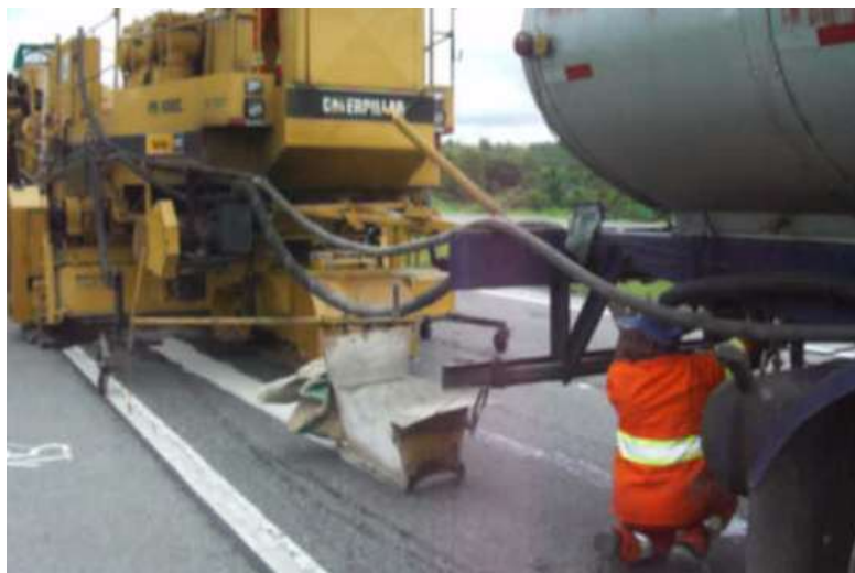
Figura 48 – Distribuição de aditivo antes da fresagem
