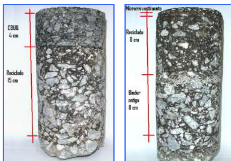
Figura 63 – Corpos-de-prova extraídos por sonda rotativa do trecho experimental indicando as características das estruturas executadas
