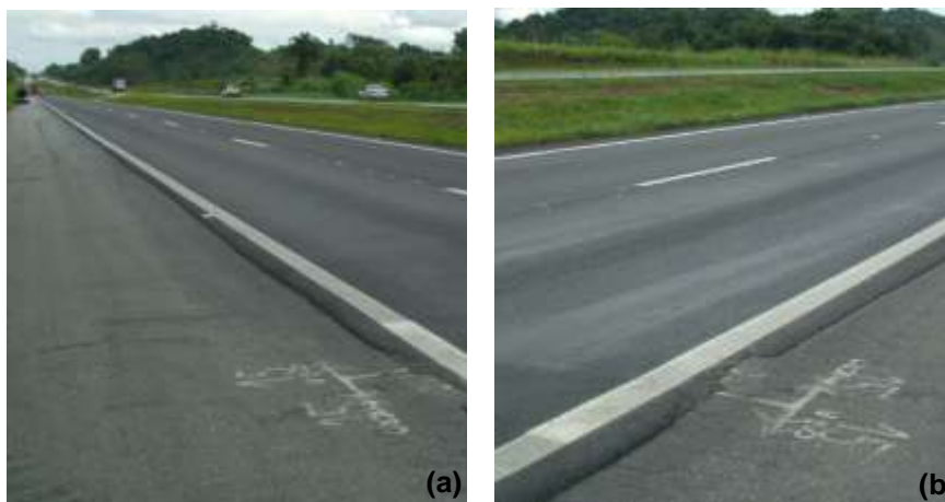
Figura 70 – Segmentos reciclados com cimento e camada de revestimento em concreto asfáltico (a) e em microrrevestimento (b), respectivamente – Imediatamente após restauração – março/2009
