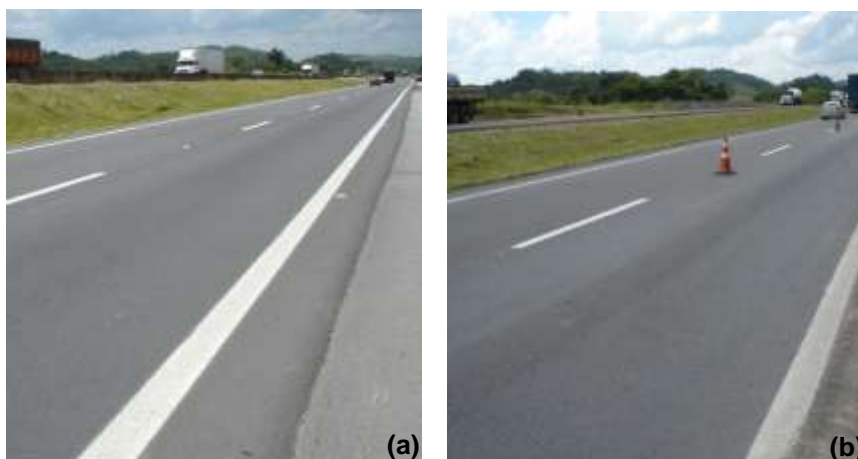
Figura 71 - Segmentos reciclados com cimento e camada de revestimento em concreto asfáltico (a) e em microrrevestimento (b), respectivamente – após um ano de vida em serviço – março/2010
