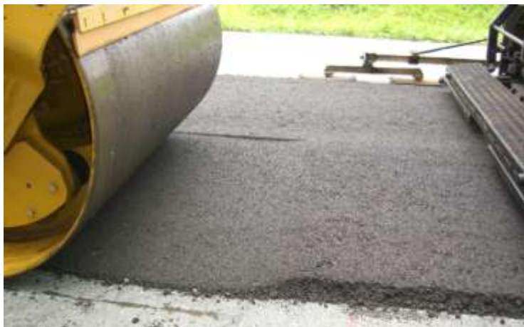
Figura 59 – Compactação com rolo chapa
