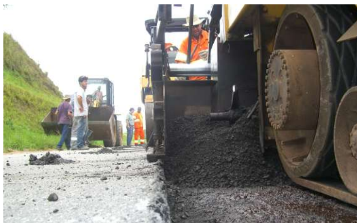
Figura 57 – Vibroacabadora com distribuição por rosca sem fim
