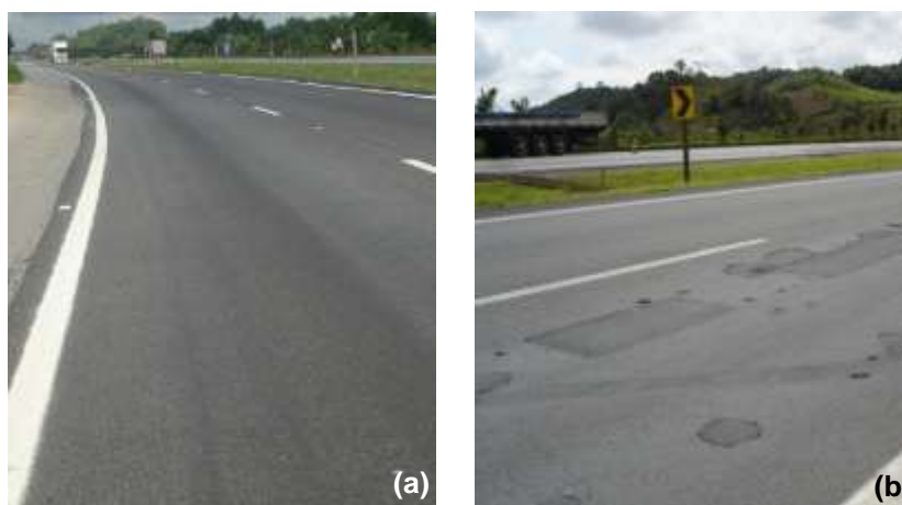
Figura 61 – Segmentos de reciclagem com cal e microrrevestimento, respectivamente em março/2009 (a) e março/2010 (b)
