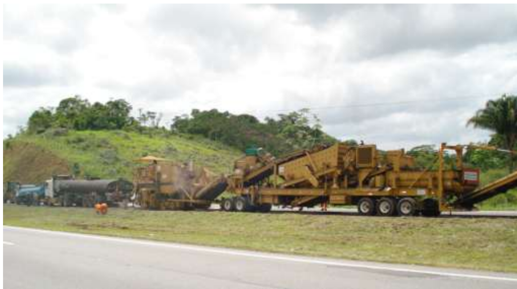
Figura 46 – Trem de reciclagem utilizado na restauração do trecho experimental
