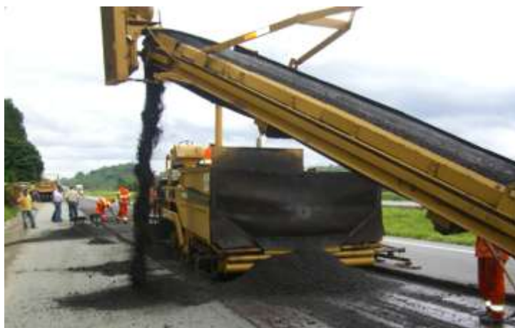
Figura 58 – Acabadora desconectada do trem de reciclagem
