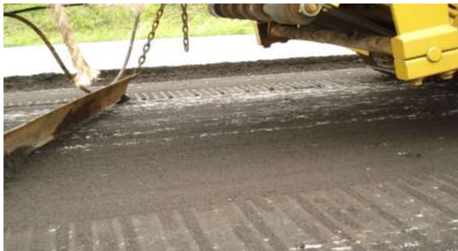
Figura 45 – Aparência superficial homogênea do pavimento após a fresagem
