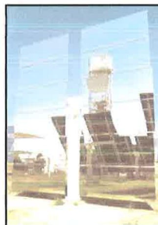
Figura 2.19. Foto de um heliostato pertencente ao sistema de torre solar de Almeria. Fonte: CIEMAT (2001).
