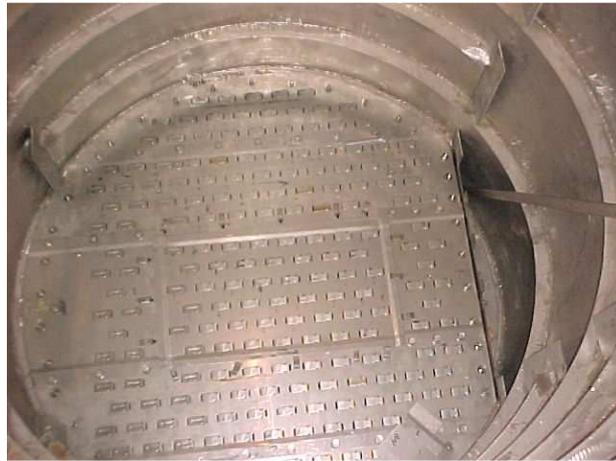
**Figura 2.8** Vista superior de prato valvulado durante a montagem.
