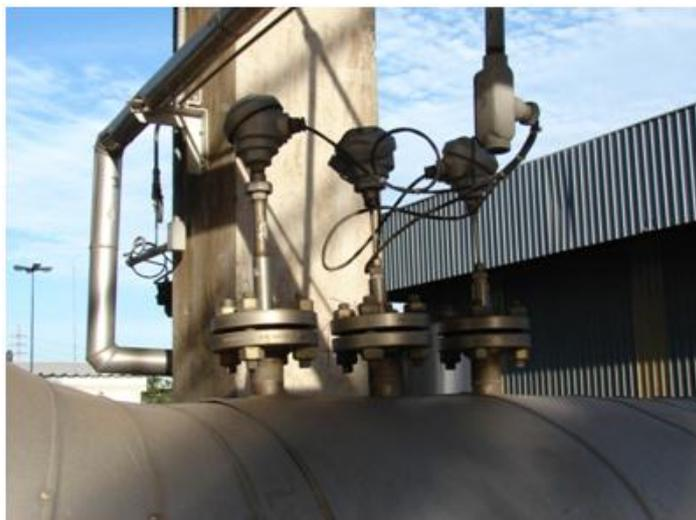
Figura 32 – Detalhe do sistema de medição de temperatura da reação
