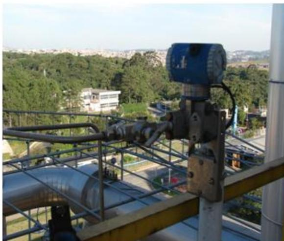
Figura 35 – Detalhe do instrumento de medição da pressão da reação
