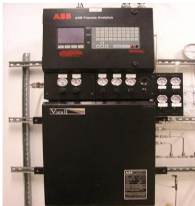
Figura 36 – Analisador de vazão de clorados para o sistema de gás de reciclo
