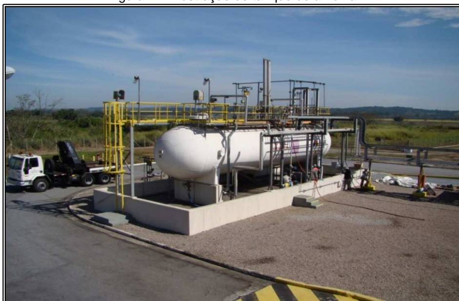
Figura 24 - Ilustração de tanque de amônia.
