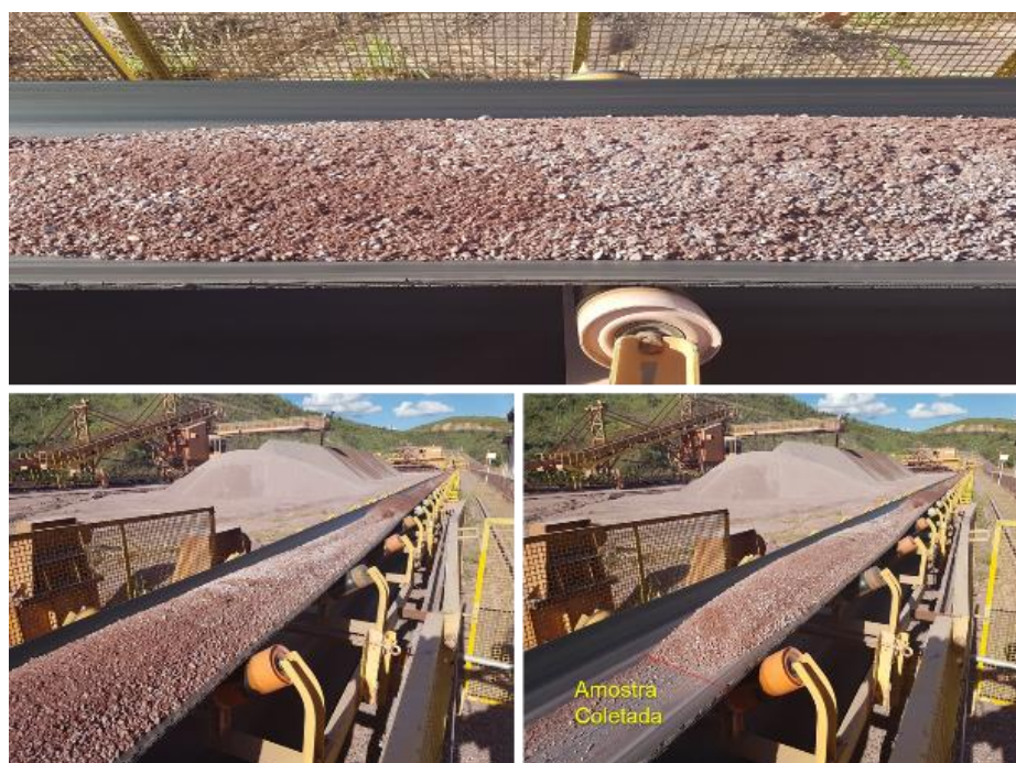
Figura 36. Amostragem realizada na correia transportadora que alimenta a moagem
