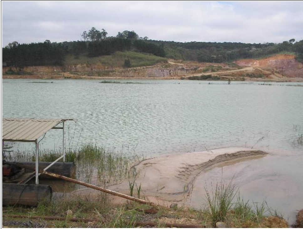
Foto 3.17 – Lagoa ou tanque de clarificação. Deste local a água é recuperada e reutilizada no processo de lavra e beneficiamento. (Foto: autor).
