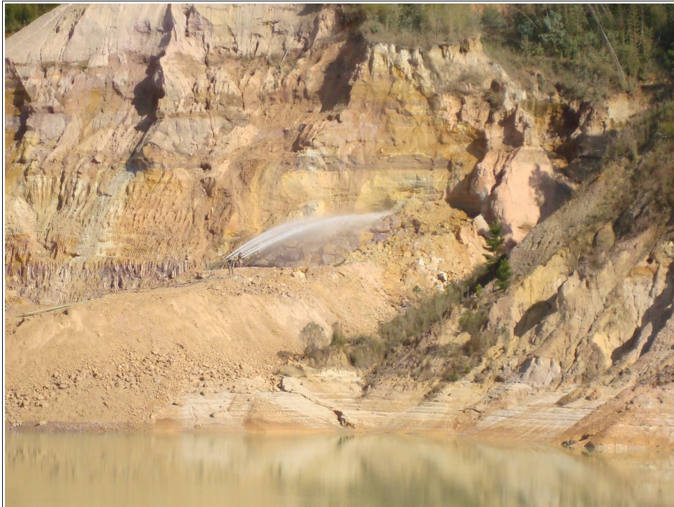
Foto 3.9 – Extração do minério por processo de desmonte hidráulico. (Foto: autor).
