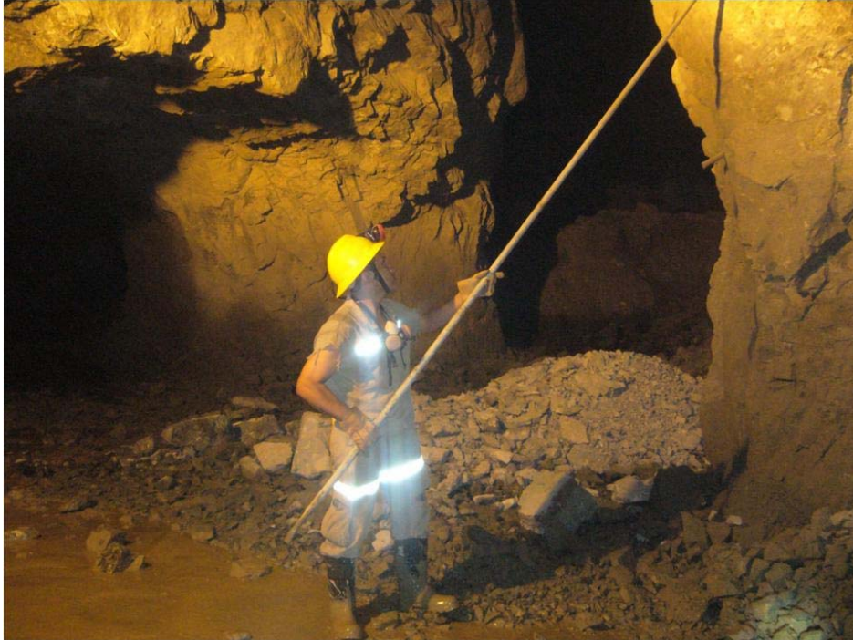
Figura 3.11 - Retirada manual de rocha solta (Fotografia da minera Condestable)
