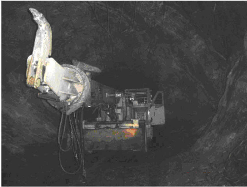
Figura 3.12 - Retirada mecanizada de rocha solta com scaler (Faria, 2008)
