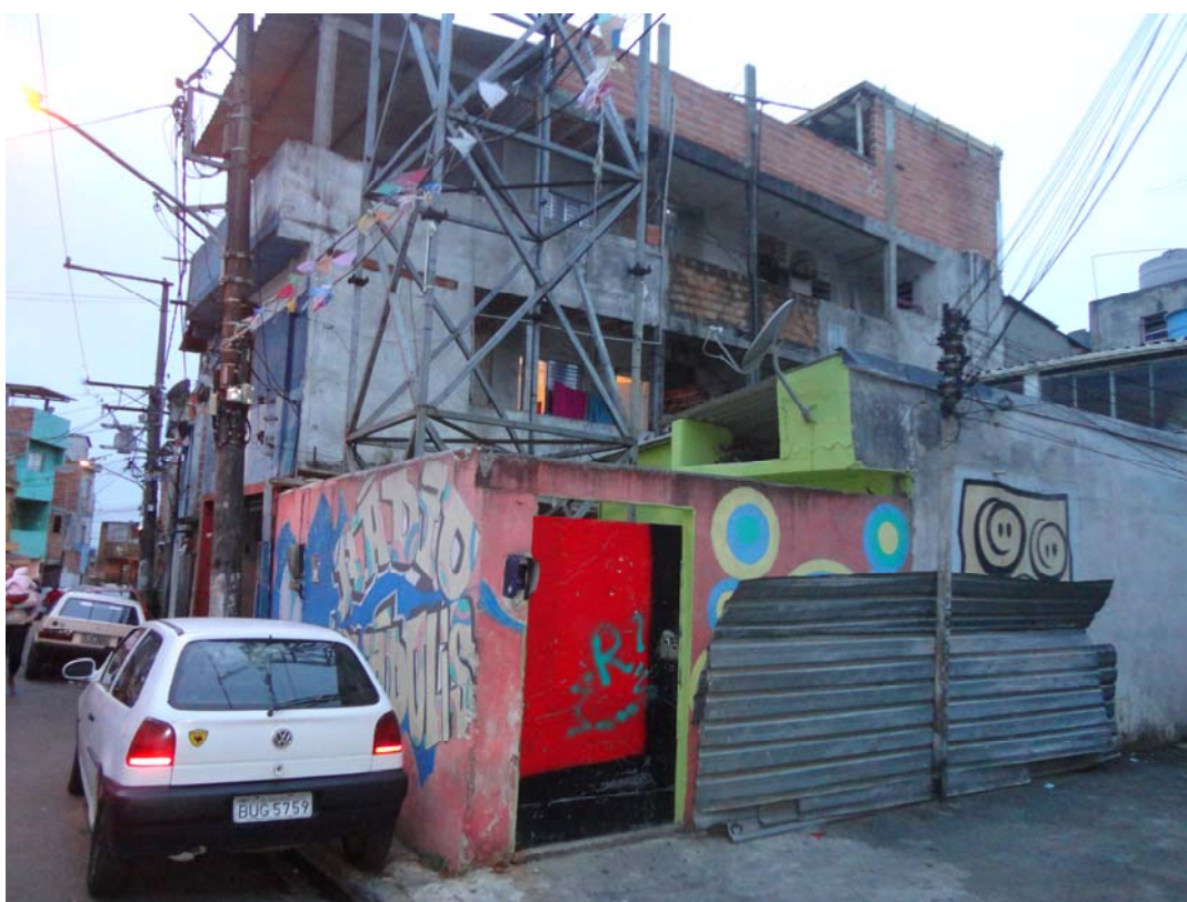
Foto 15 – Sede da Rádio Heliópolis durante reforma.
