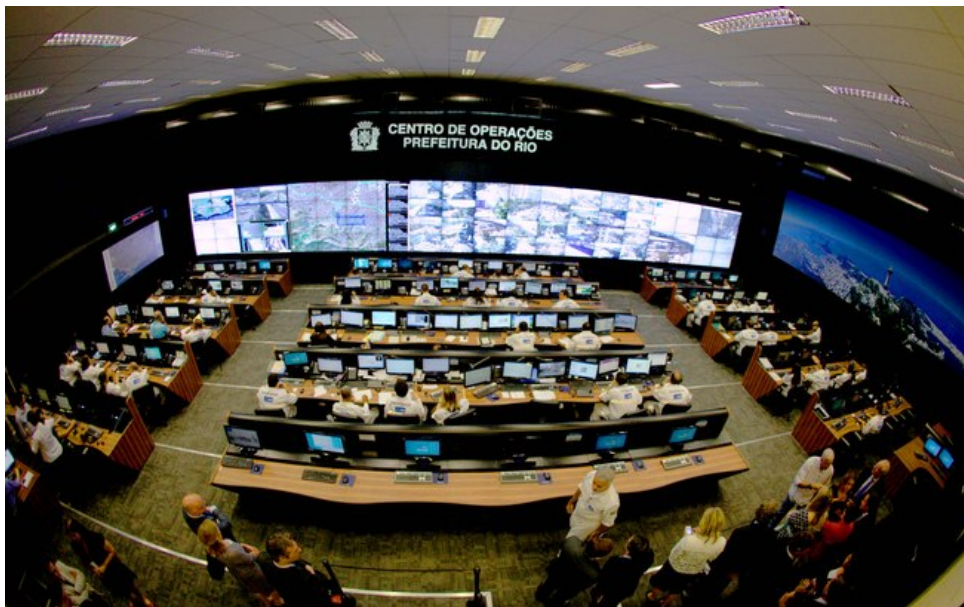
Figura 35: Vista da central de controles do COR
