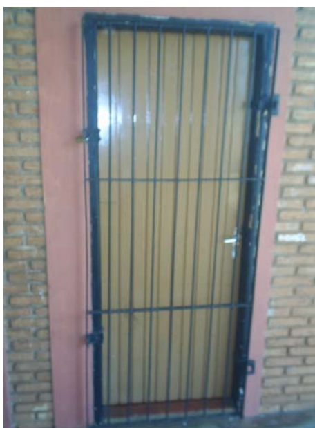
Figura 17 Reforço da segurança, na UE 3, que instalou porta dupla (madeira maciça e grades), visando minimizar os roubos na sala de depósito de merendas.
