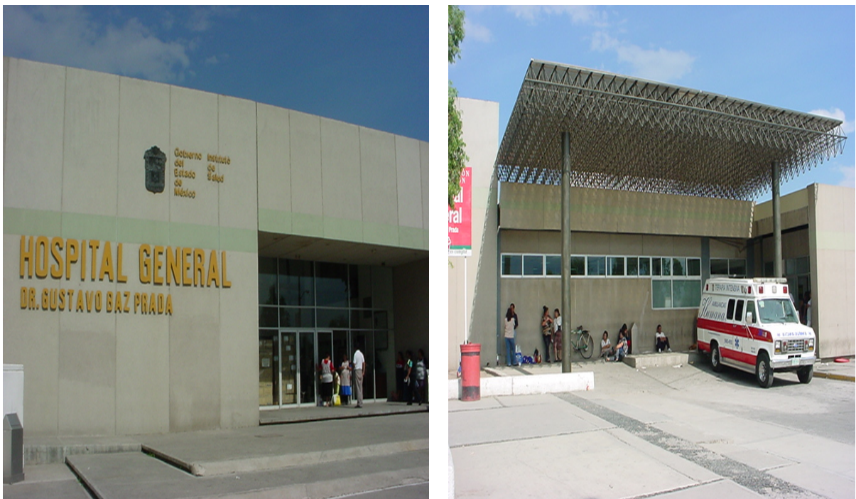
Figura N°2- Fotos da fachada do Hospital General Dr Gustavo Baz Prada/ Nezahualcoyotl
