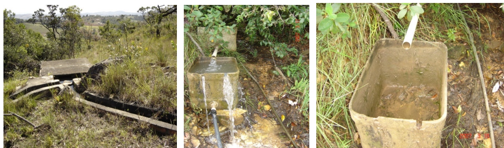
Figura 6 – Caixas de alvenaria e de amianto para armazenar água
