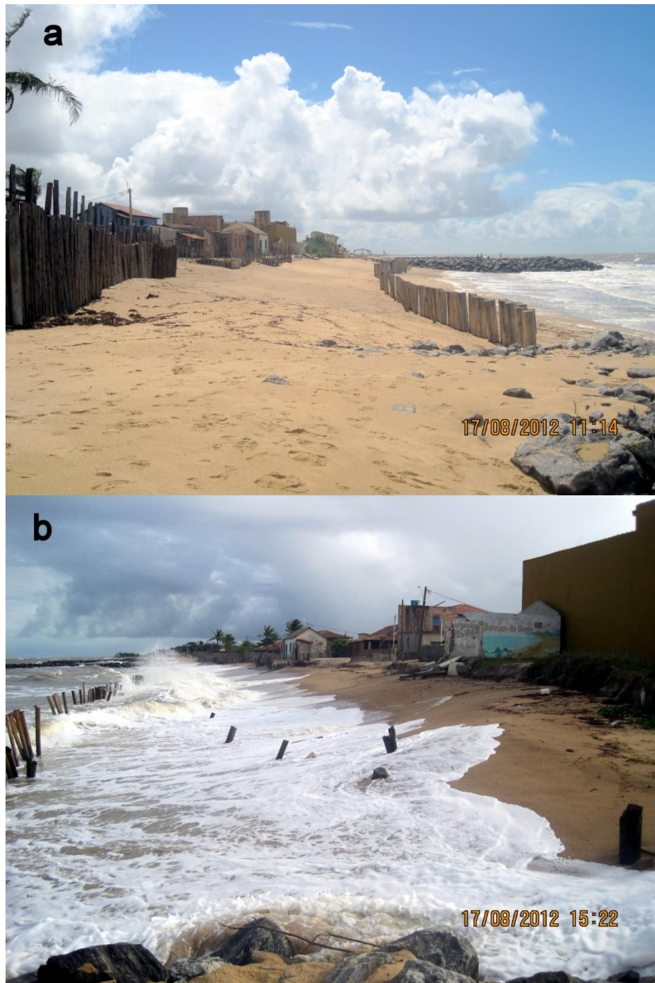
Figura 21: Imagens de uma das obras de contenção feita pela prefeitura em Mucuri (BA). Essa obra consiste em um “muro” de toras de madeira, que atenuam a energia das ondas que chegam à costa. A foto “a” mostra a vista norte dessa contenção, na maré baixa, enquanto que a foto “b” mostra a vista sul, na maré alta. Fotos: Juliana S. Ribeiro
