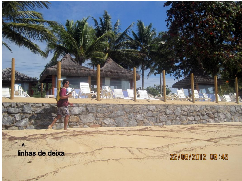
Figura 45: Muro de pedras, estrutura de proteção costeira. Foto: Juliana S. Ribeiro
