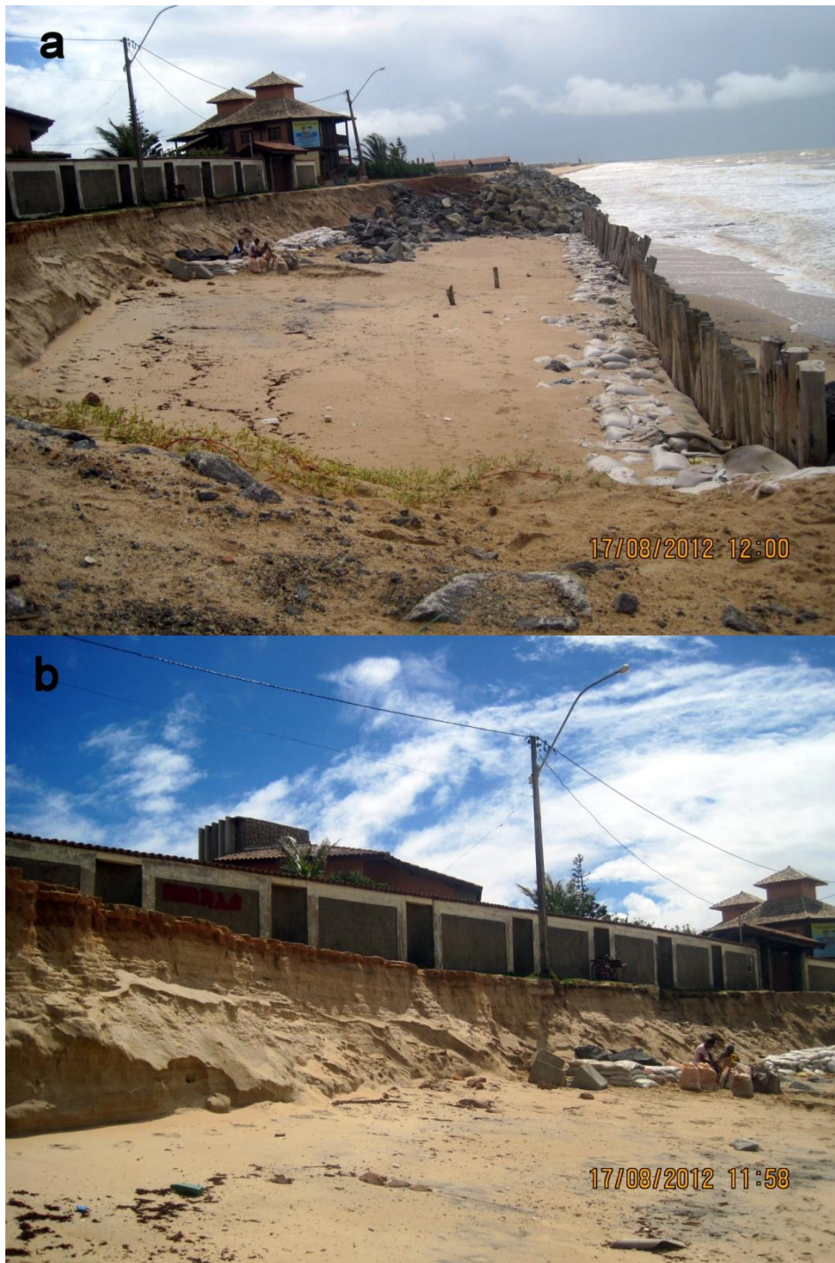
Figura 24: Vista do ponto crítico de erosão costeira em Mucuri (BA). A foto “a” mostra a vista sul, no topo da depressão do terreno. Nota-se a presença do muro de contenção de madeira, além de sacos de areia no terreno. A foto “b” mostra o detalhe da depressão, vista de baixo. Fotos: Juliana S. Ribeiro
