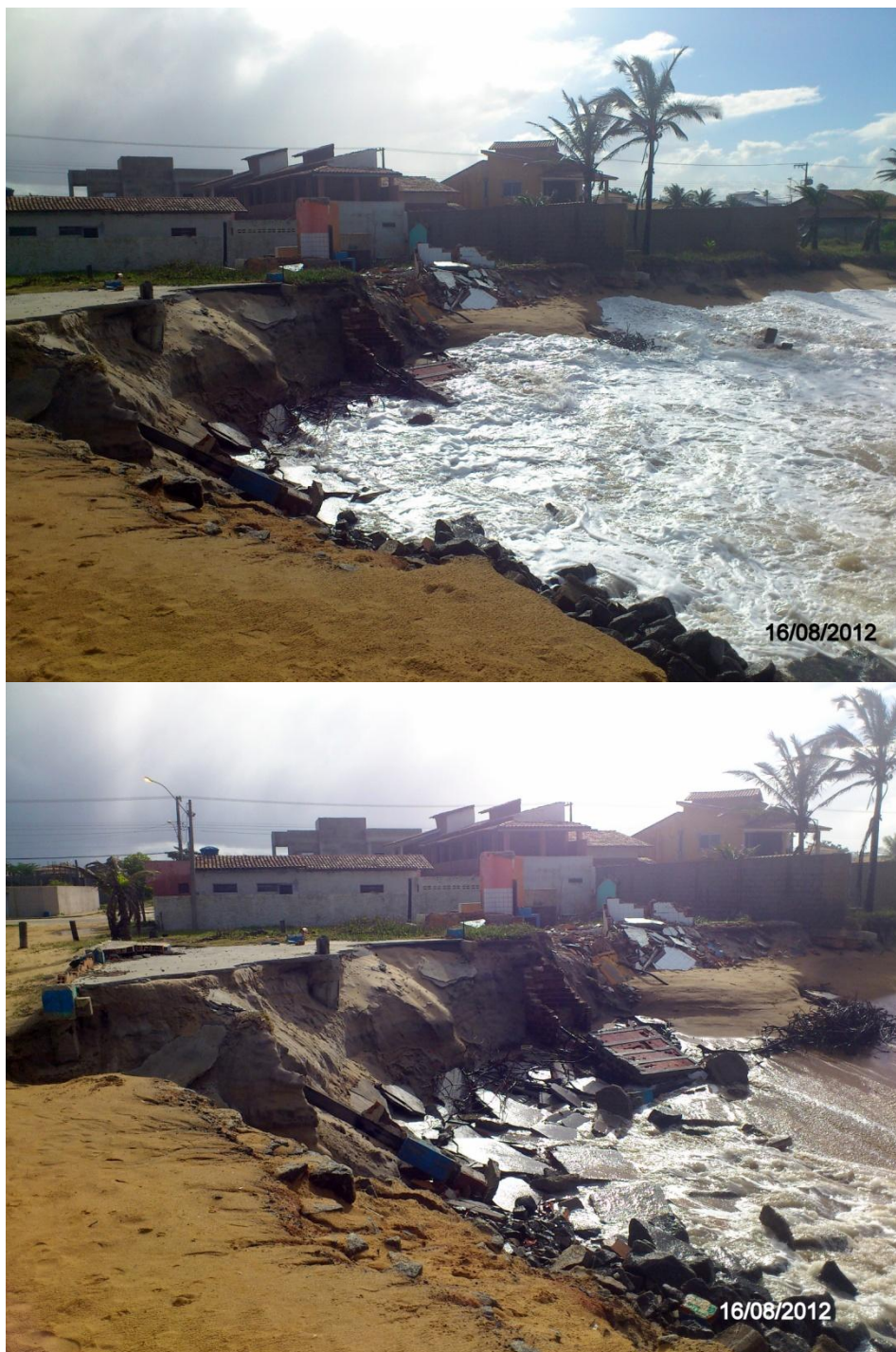
Figura 18: Imagens do ponto crítico de erosão em Conceição da Barra, ES. Fotos: Paulo H. G. O. Sousa
