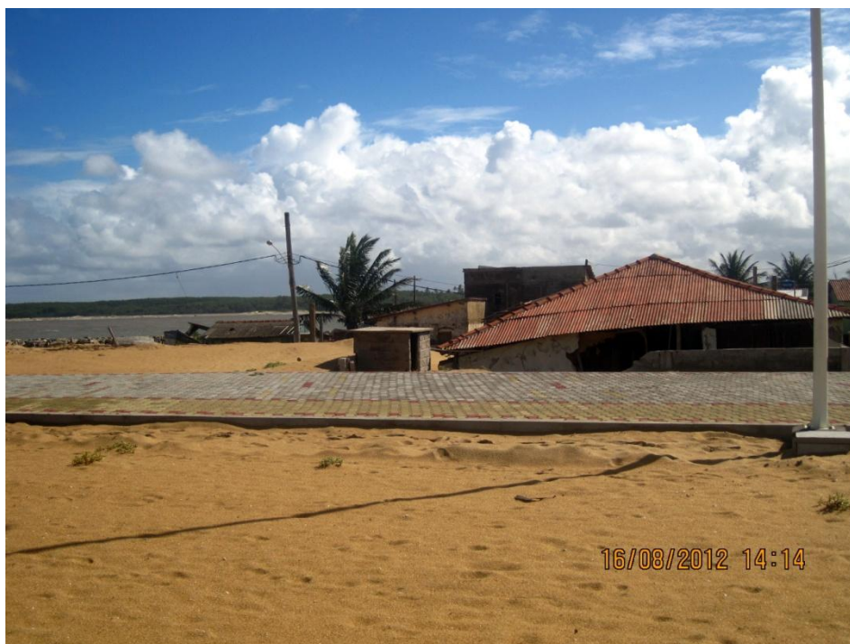
Figura 17: Imagem de uma casa localizada próxima à foz do rio Cricaré. A casa foi destruída pela erosão costeira, provavelmente no período anterior às obras de proteção da orla. Foto: Juliana S. Ribeiro
