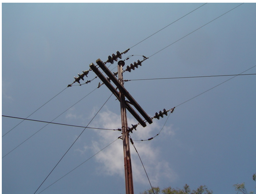
Figura 3.10 – Estrutura do Tipo "E"
