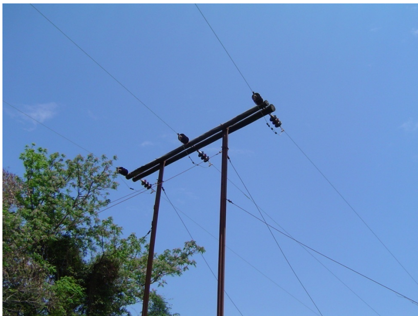
Figura 3.12 – Estrutura do Tipo "HT"
