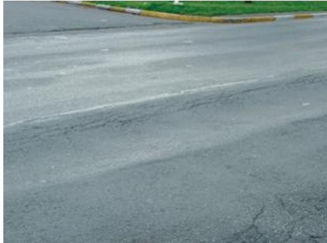
Figura 17 - Deformação permanente - segunda ilustração
