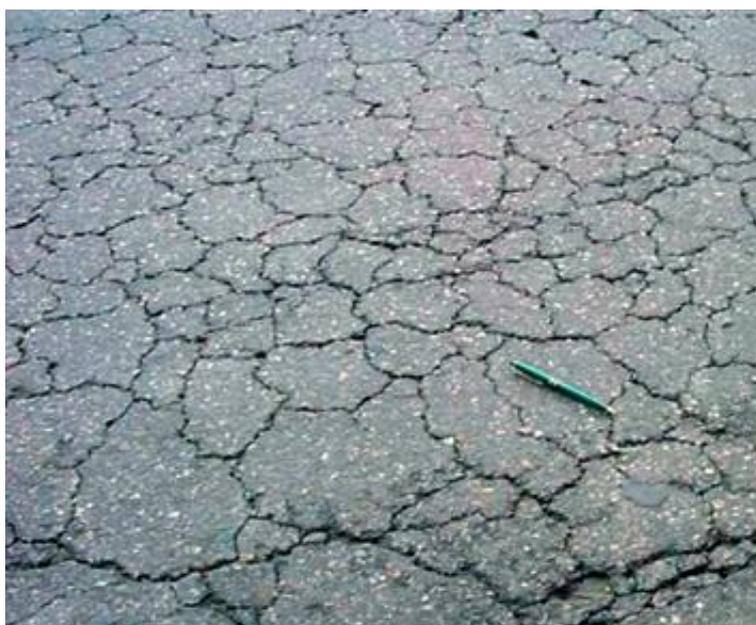
Figura 16 - Trincas por fadiga - segunda ilustração
