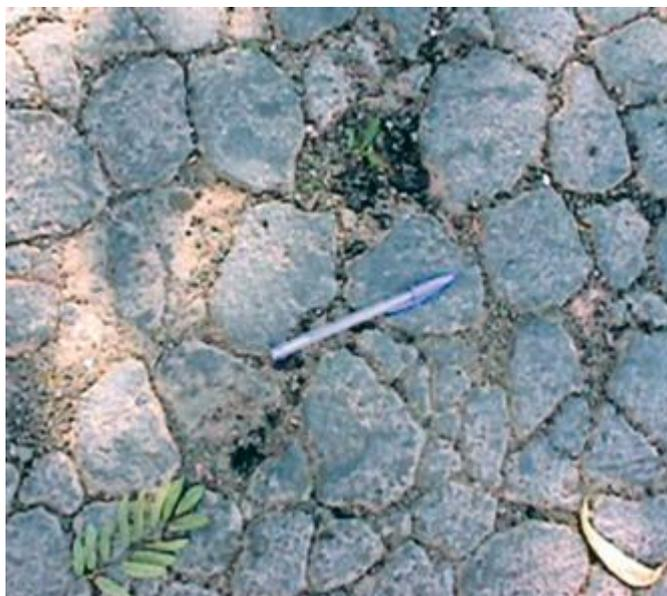
Figura 34 - Trincas por Fadiga com erosão
