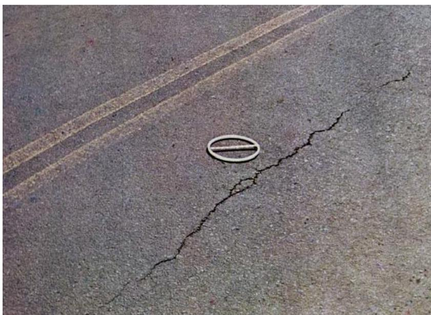
Figura 4 - Trinca longitudinal fora das trilhas de roda
