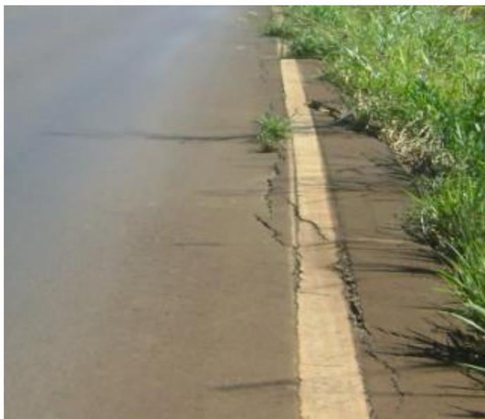
Figura 3 - Trincas nos bordos
