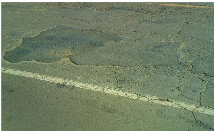
Figura 37 - Remendo de grandes proporções não sanando completamente o problema
