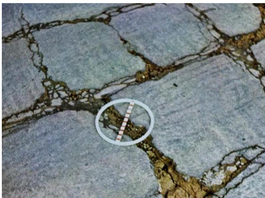
Figura 2 - Trincas em blocos
