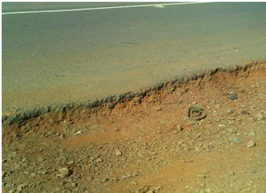
Figura 14 - Desnível entre pista de rolamento e acostamento não pavimentado
