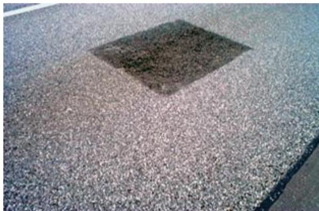
Figura 7 - Remendo 'bem' executado
