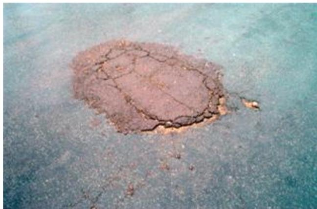
Figura 18 - Remendo 'mal' executado
