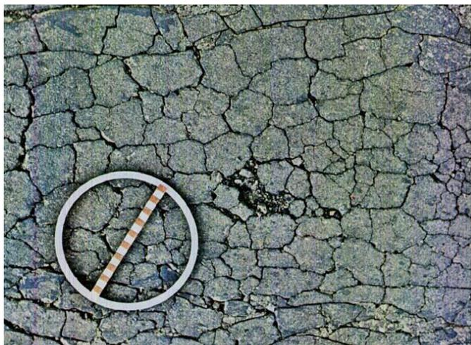
Figura 1 - Trincas por fadiga
