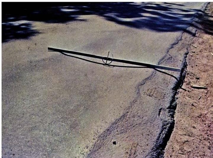
Figura 9 - Deformação Permanente nas trilhas de roda
