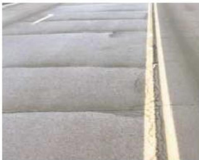
Figura 5 - Trincas por reflexão em juntas
