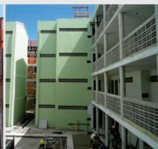
BRAGA, Jul. 2012 Obras na área interna do conjunto
