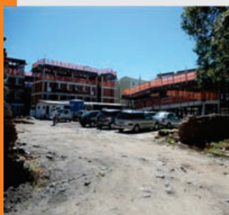
BRAGA, Jul. 2012 Canteiro de obras
