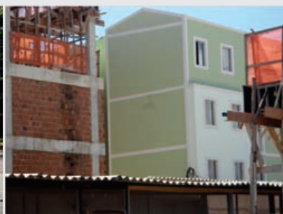
BRAGA, Jul. 2012 Construção das unidades habitacionais
