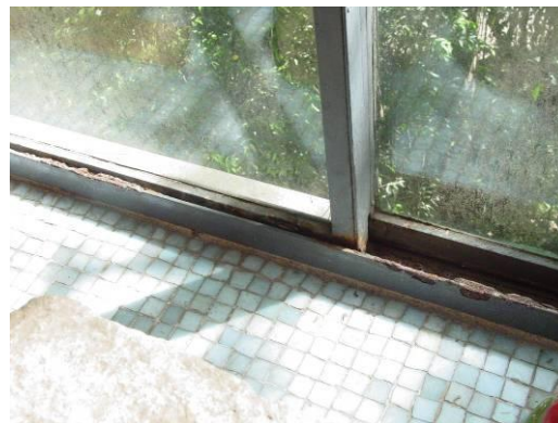
Figura 8. Detalhe do trilho-guia junto ao piso da Casa de Vidro.
