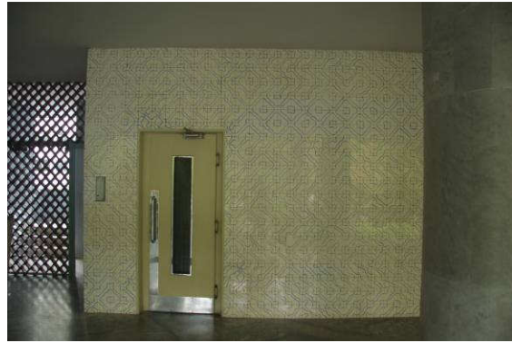
Figura 42. Chegada do elevador no térreo-mezanino. Vedação revestida em azulejos.
