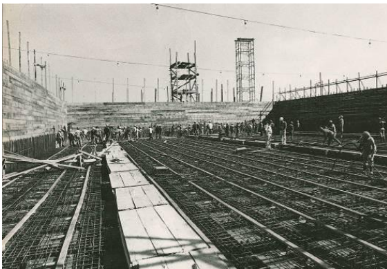
Figura 50. Concretagem de uma das lajes. As paredes desse pavimento ainda estão enformadas com as tábuas na horizontal e as formas das aberturas, feitas em EPS presas em seu interior.
