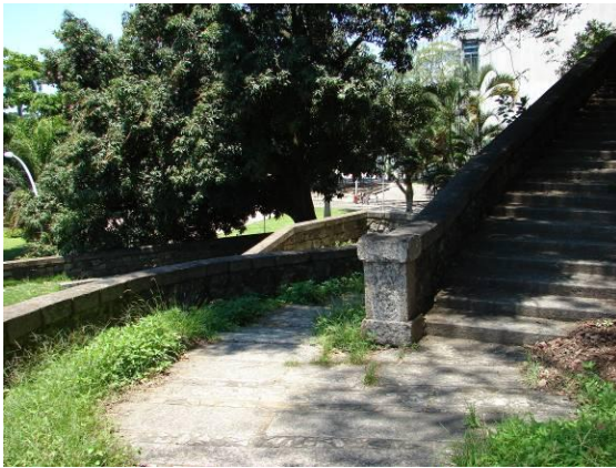
Figuras 24. O arrimo surge do outro lado como peitoril. Vê-se o acabamento superior do peitoril, com pingadeiras, de excelente execução.
