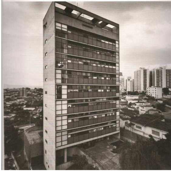
Figura 59. Empena contínua, desde o chão – Paulo Mendes da Rocha, Edifício Jaraguá, 1984.
