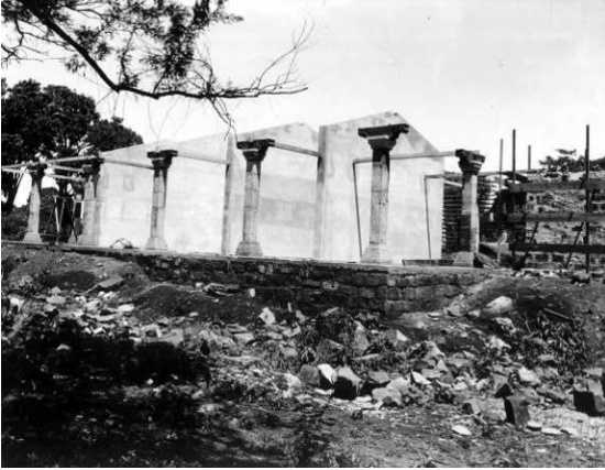
Figura 50. O museu em obras.
