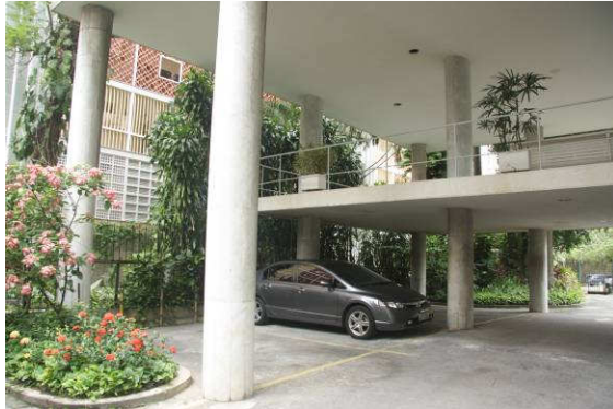
Figura 39. Mezanino, como uma ponte sobre o acesso às garagens.
