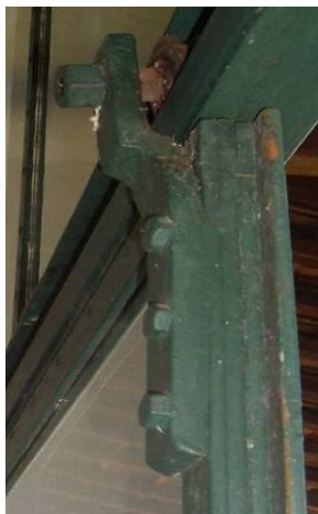
Figura 5. Detalhe do nicho-suporte do rolamento do caixilho do Museu das Missões. O rolamento corre interno ao grupo – trilho fechado.
