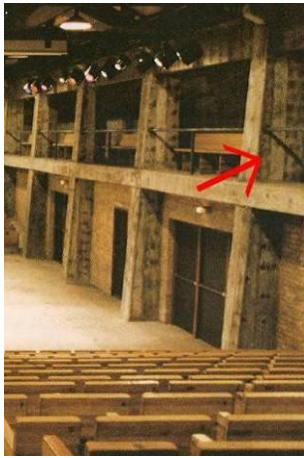
Figura 13. Vista dos pilares do Teatro: em tom mais claro, o pilar original, e os reforços, mais escuros e com a forma marcada no concreto, inclusive os nós da madeira de forma.
