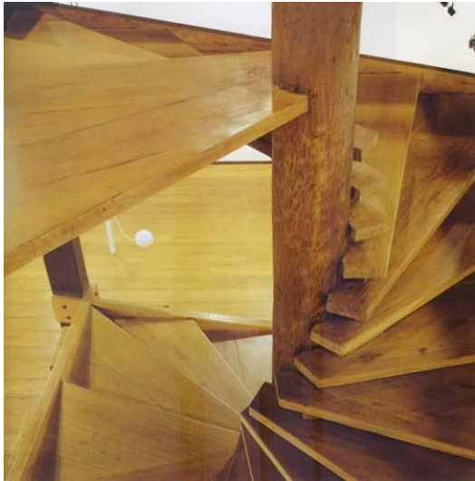
Figura 1. Direção tangente dos degraus em relação ao grande pilar central.
