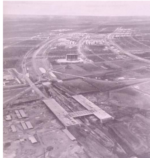
Figura 9. Construção da Rodoviária de Brasília, com vista para a Asa Sul.
