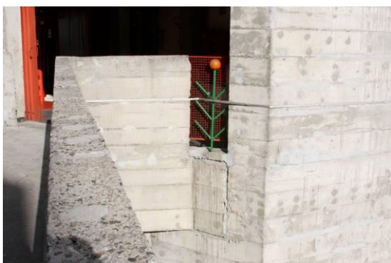
Figura 57. Flor de mandacaru e a grade colocada depois. Vê-se nitidamente o encaixe Guerber. Sem comentários sobre a fita de pára-raios.
