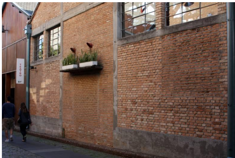
Figura 81. Os tijolos “claros” são obturações novas, sacando-se o antigo, em decomposição. Mas permaneceram as manchas da existência de portas ou janelas, do tempo da antiga fábrica .
