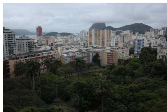
Figura 52. Terraço-ocupável dos edifícios, como foi executado.
