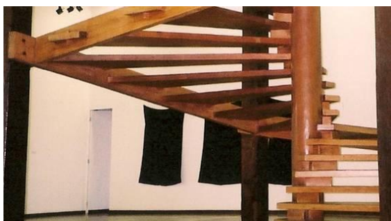
Figura 16. O sistema concebido preserva a integridade do pilar central, através do tarugo espaçador. Ao mesmo tempo os próprios degraus travam o pilar na estrutura pré-existente, através das vigas inclinadas das bordas.
