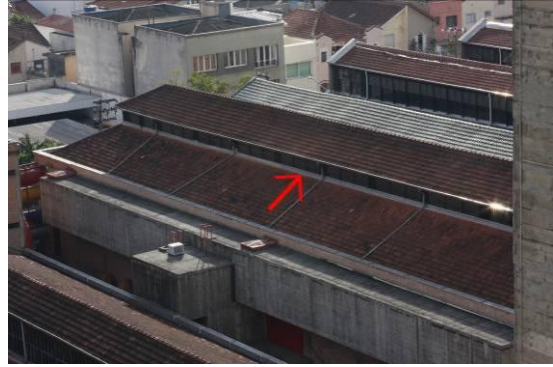
Figura 22. Detalhe da cobertura com lanternim do galpão, em foto atual.
