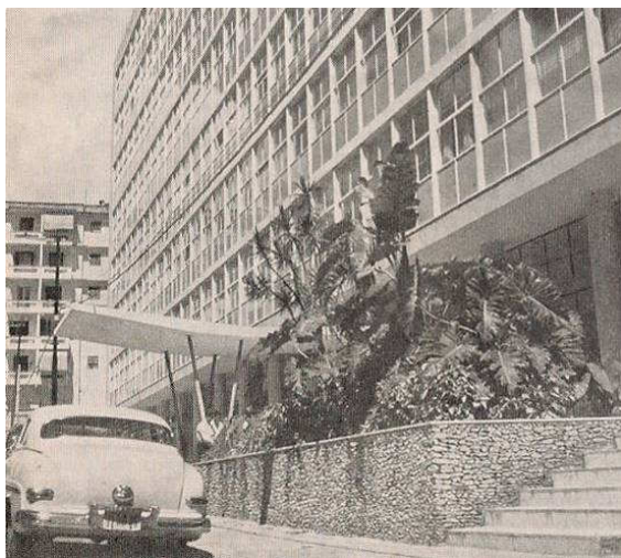
Figura 23. Edifício Nova Cintra, ainda sem a grade que existe hoje. Só o desnível demarcava o fora e o dentro. A marquise comercial é o recuo do caixilho das lojas e a residencial é o longo convite .
