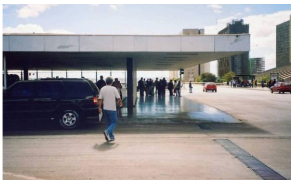
Figura 14. Rodoviária de Brasília: a marquise é tão singela que quase não se percebe sua importância no todo do funcionamento da cidade.
