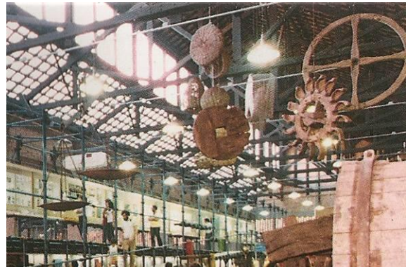
Figura 20. A primeira Exposição feita por Lina no SESC foi Design no Brasil. As pesadas rodas d'água ficaram penduradas por mais de 6 meses: prova de carga efetiva da segurança das tesouras.
