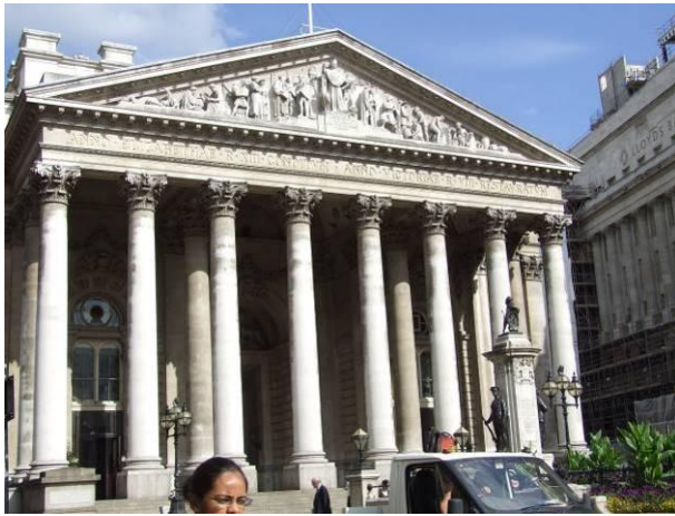
Figura 1. Fachada de Bancos em Londres. Primeiro plano: Royal Exchange e segundo plano, à direita: Lloyd's Bank. O pórtico da entrada se reporta ao Panteão em Roma, com a dupla fileira Colossal .
