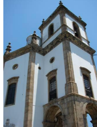
Figura 7. À direita os cunhais, livres da sacada, em toda sua verticalidade acentuada pela terminação com coruchéus.
