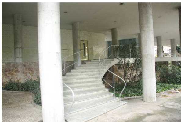
Figura 46. Escada em leque, implantada a meio nível em relação à declividade da rua e o mezanino – que passa a ser térreo no outro extremo; a escada começa no degrau convite , enquanto o guarda-corpo metálico faz a curva-bengala , aumentando o convite. A escada foge da malha estrutural do conjunto.
