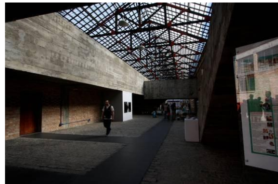
Figura 10. Foyer do Teatro e acesso às Galerias. Contraluz, que mascara o vermelho dos reforços, que permite ver melhor as tesouras, sem as novas interferências.
