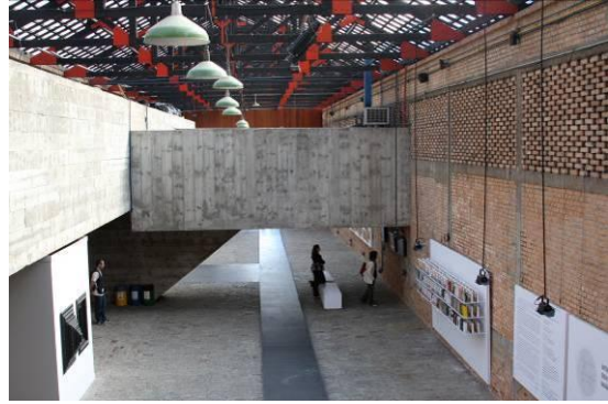
Figura 12. Vista do Foyer. Galerias e Camarins. O atual reforço das tesouras, pelos nós, ficou excessivo, parecendo uma decoração.
