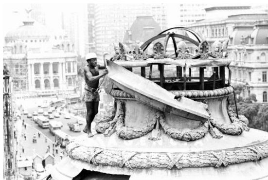
Figura C: Desmontagem do Palácio. 1975.
