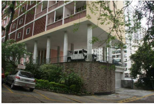
Figura 45. Entrada do estacionamento do Caledônia; é o edifício mais próximo do limite de vizinhança de todo o conjunto, com a manobra de veículos mais restrita. As garagens ocupam o subsolo e a cantaria é, em parte arrimo, em parte vedo do sub-solo.
