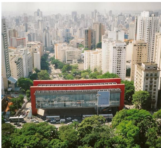
Figura 38. Desde 1990 o MASP ostenta pilares e travessões vermelhos, conforme o projeto original de Lina.
