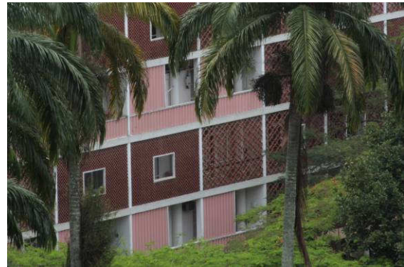
Figura 59. A desmodulação da estrutura com os requadros do combogó é claramente vista de fora; reencontra-se através do ajuste que ocorre no balanço até as empenas: comodulação .
