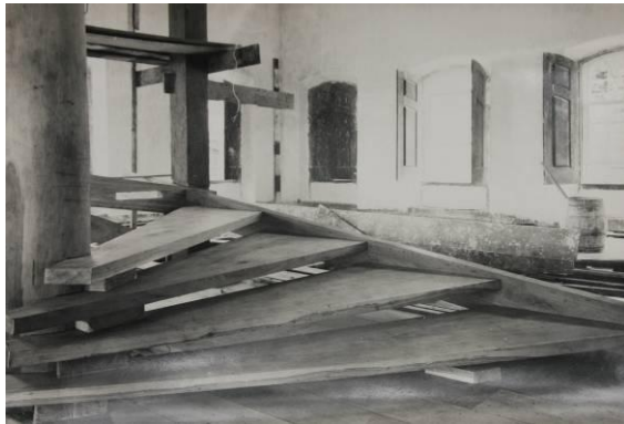
Figura 19. A montagem da escada: andaime de si mesma .
