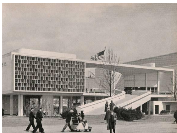
Figura 18. Pavilhão do Brasil em Nova York. 1939. O plano formado pela face vertical da laje de piso segue pelas empenas com a mesma espessura e se encontram na face vertical da laje de cobertura; o combogó é saliente em relação a esse plano, como os antigos muxarabis.
