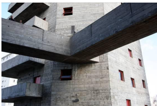
Figura 56. Passarela como articulação entre os dois prédios do Bloco Esportivo: encaixe Guerber e guarda corpo com recortes de acomodação.
