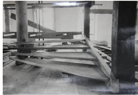
Figura 20. A montagem, de tão simplificada, dispensa andaimes auxiliares.
