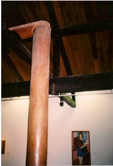
Figura 15. Detalhe do pilar central, escada do Solar do Unhão. A peça no topo do pilar é simplesmente uma prateleira que Lina usou na Exposição Nordeste, onde deveria ter ficado, para sempre, a imagem do Caboclo . O pilar é solto do ponto de vista estrutural em seu trecho de cima.
