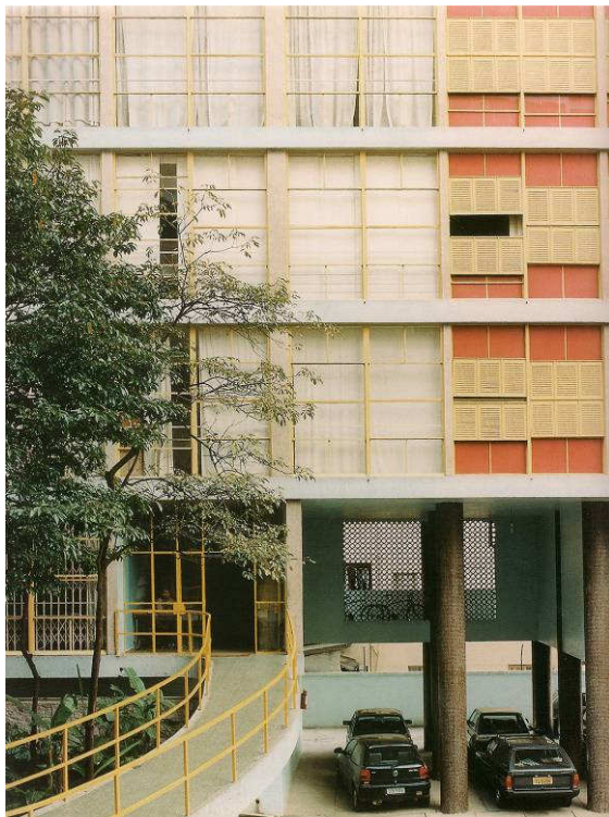
Figura 35. Edifício Louveira: ponte que leva à casa do zelador, com o combogó voltado para o pé-direito duplo, e os pilares soltos , a plena altura. Vilanova Artigas. São Paulo. 1946.
