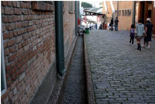
Figura 37. Canaletas de água pluvial SESC Pompéia.
