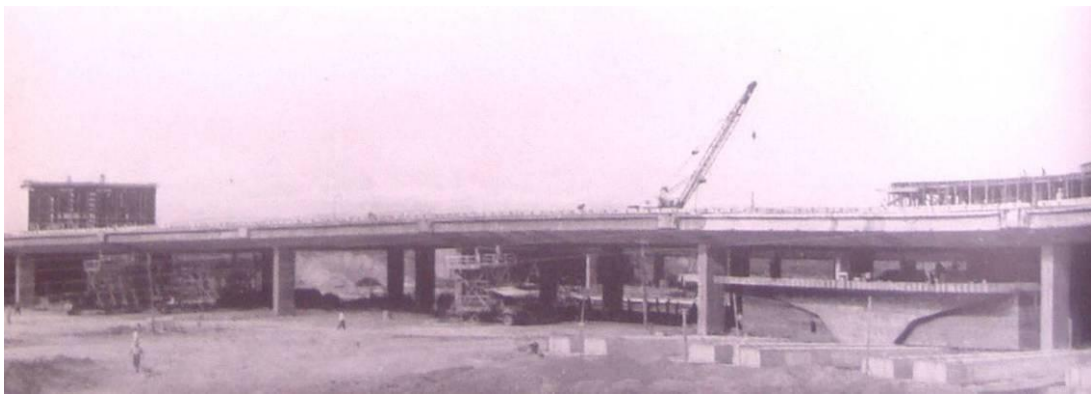
Figura 10. Construção da Plataforma Rodoviária de Brasília. À direita vê-se o pilar “T” dos mezaninos ainda escorado, em fase de concretagem.
