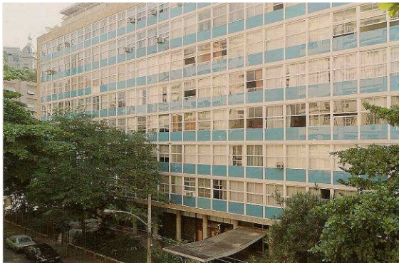
Figura 53. Fachada do Edifício Nova Cintra, com os peitoris das janelas em azul shocking , enquanto o original era o azul pálido da paleta característica de Lucio. Se comparada com a imagem 20, desse capítulo, vê-se também a retirada do montante intermediário de sustentação de cada um dos requadros desse peitoril. Vidros temperados – esses, coloridos na massa – são mais resistentes, dispensando a sub-divisão com a melhor das intenções e enorme dispêndio .
