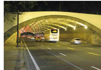
Figura 17. Túnel do Pasmado, de 1952.
