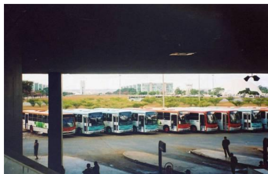
Figura 15. Rodoviária de Brasília: é uma enorme varanda que propicia conforto, sombra e ventilação, contra o sol escaldante do Planalto Central.
