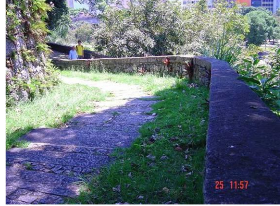
Figuras 24. O arrimo surge do outro lado como peitoril. Vê-se o acabamento superior do peitoril, com pingadeiras, de excelente execução.
