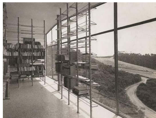
Figura 9. Caixilho da Casa de Vidro, de piso a teto. As estantes da biblioteca também eram de vidro.
