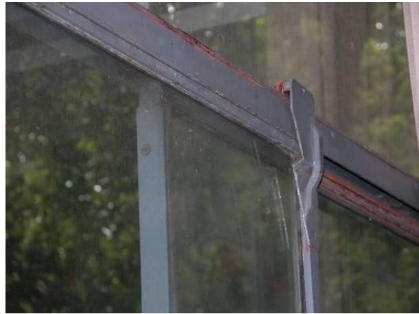
Figura 4. Caixilho da Casa de Vidro, de Lina.
