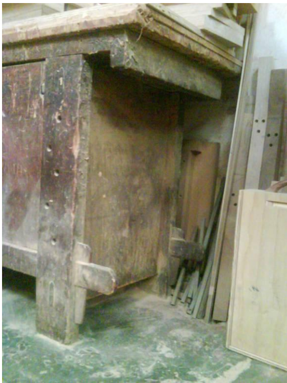
Figura 7. Encaixe espiga e cunha em bancada de marceneiro.
