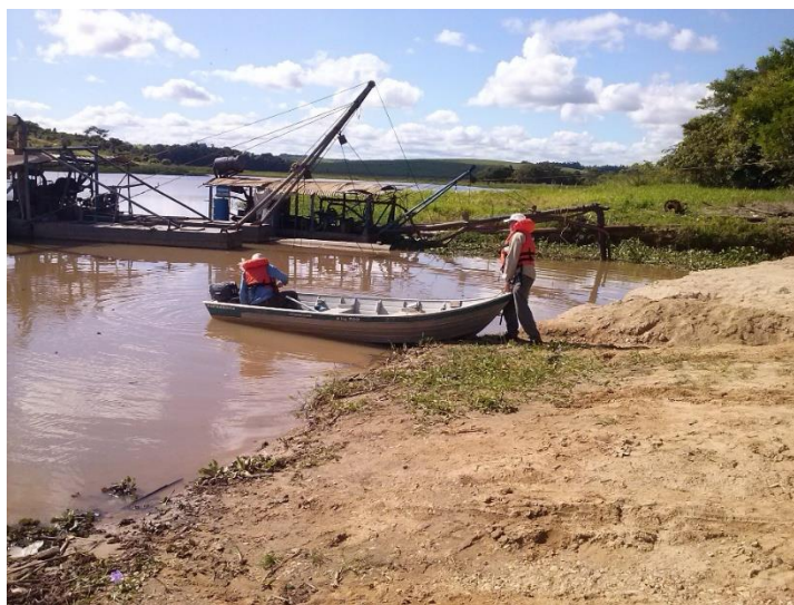
Figura 54 – Ponto de "lavagem" da areia dragada Fonte: FIPAI (2015)
