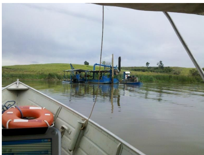
Figura 55 - Dragagens sendo realizadas às proximidades do ponto 11 Fonte: FIPAI (2015)
