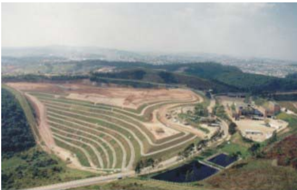
Figura 6.20 – Vista aérea do aterro sanitário de Santo André - 1998
