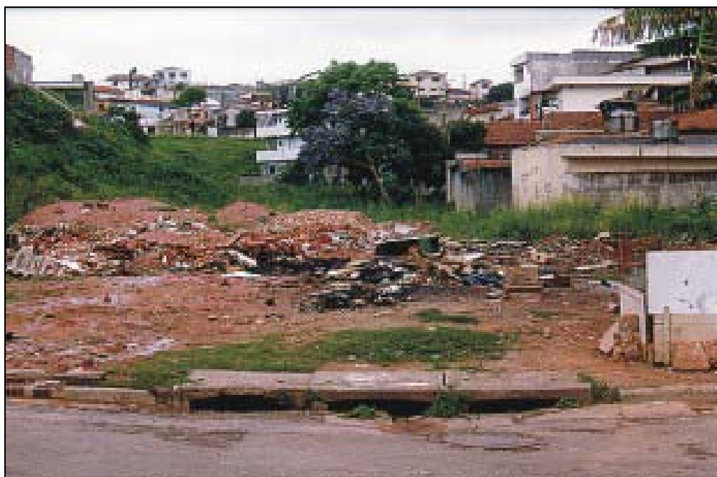
Figura 6.6 – Estação de Coleta Seletiva – situação anterior.
