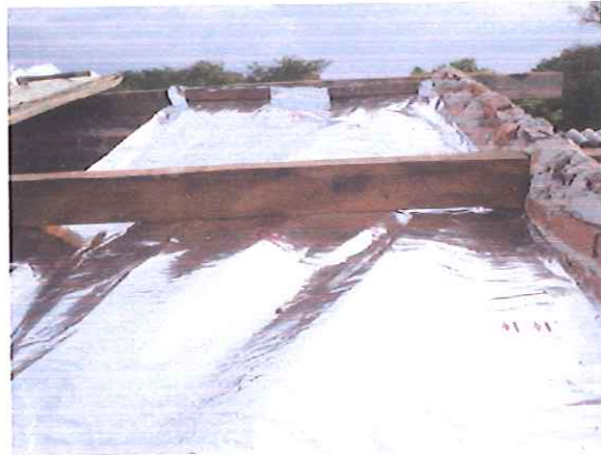
Figura 21 – colocação do foil, fixado sob as terças do telhado e nas paredes que delimitam o perímetro do ático.
