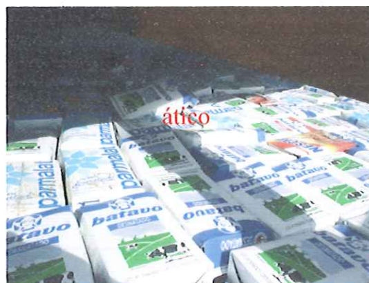
Figura 24 – vista interna do ático do protótipo 02, onde se visualiza as caixas cartonadas colocadas uma ao lado da outra sobre a laje, formando pequenas câmaras de ar entre elas.
