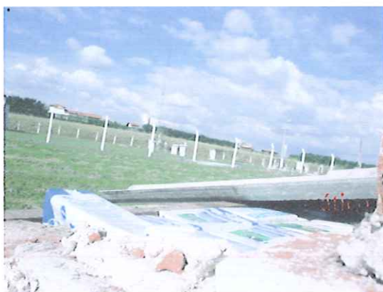
Figura 23 – Vista externa da área do ático do protótipo 02 onde foram colocadas as caixas cartonadas Tetra Pak. Pode-se ver ao fundo a estação meteorológica do CHREA.
