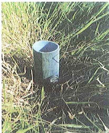
Figura 6. Piezômetro instalado no local de estudo.
