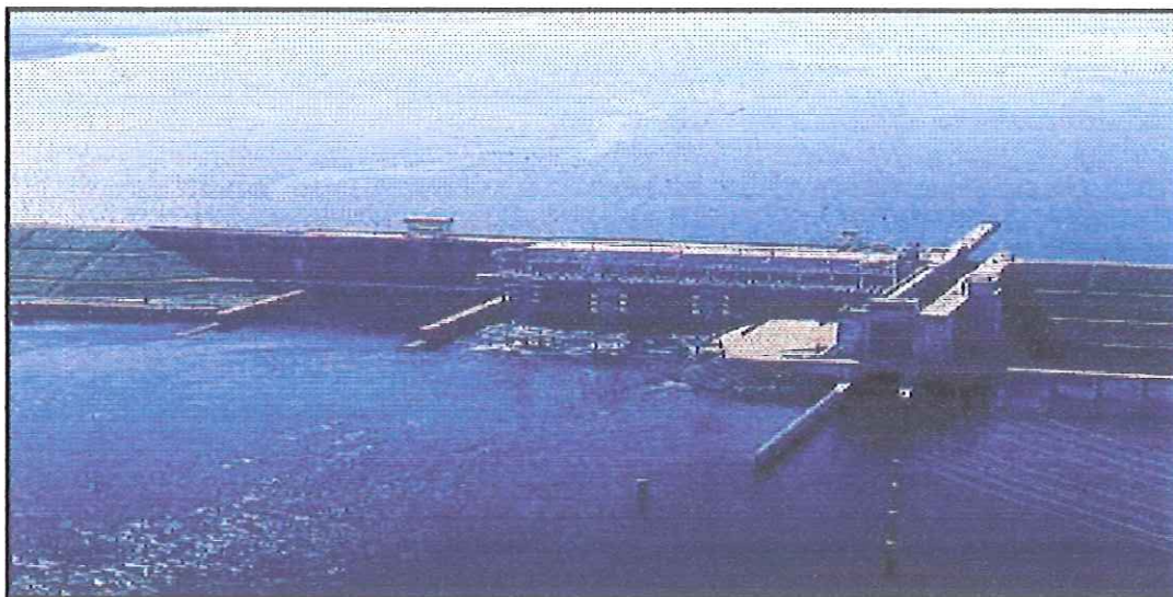
FIGURA 08 – Barragem do Reservatório de Promissão
