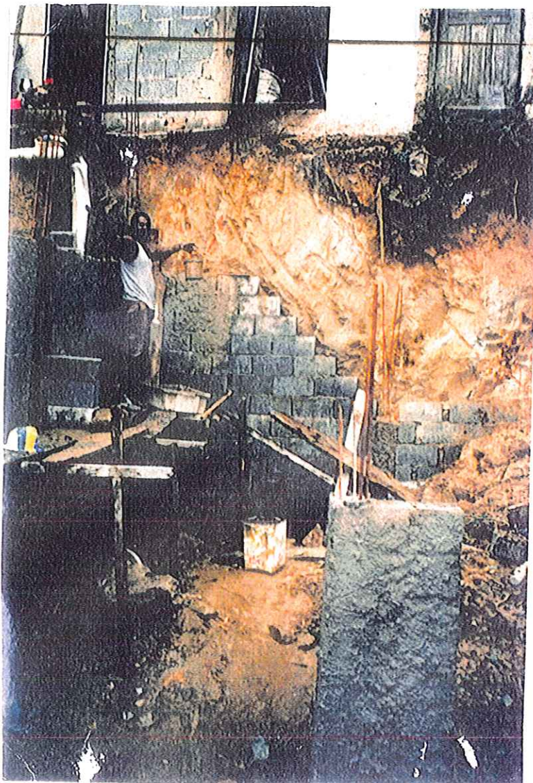
Foto 4 - Construção de residências no Morro Japuí-Prainha, evidenciando os procedimentos precários adotados
