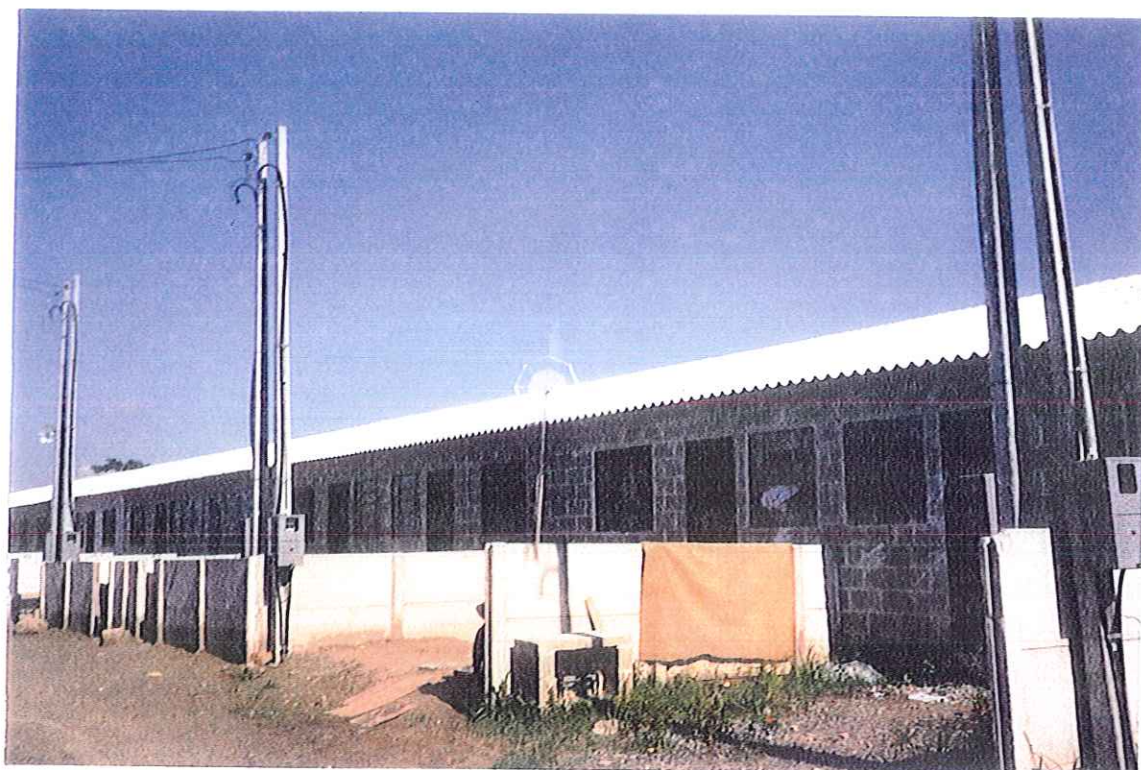
Foto 12 - Residências construídas para realocar a população dos canais de drenagem urbana
