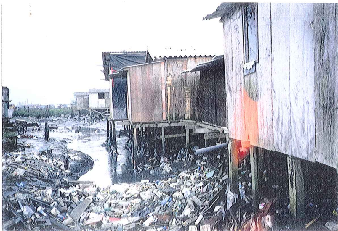
Foto 9 - Palafitas em canais de drenagem urbana
