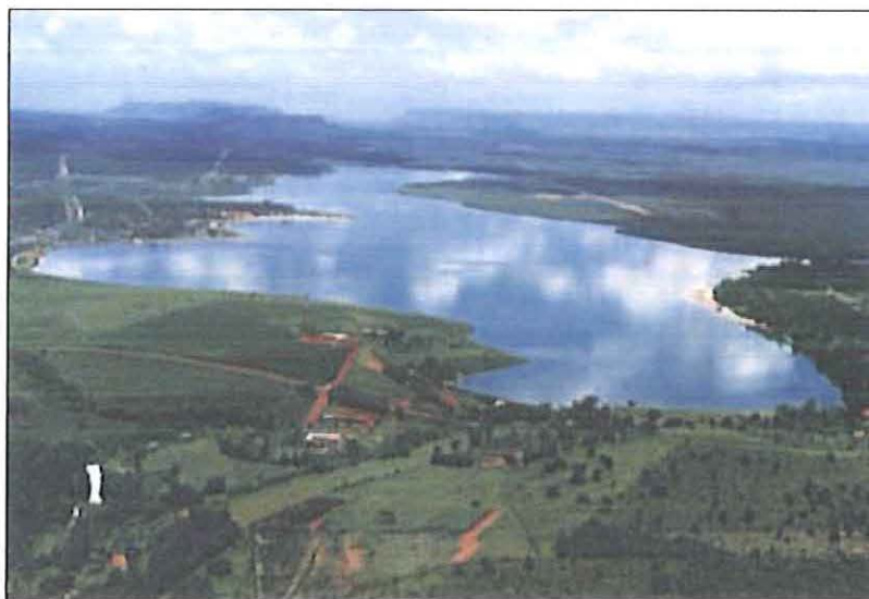
Figura 01 – Vista aérea da represa do Lobo (autor desconhecido).
