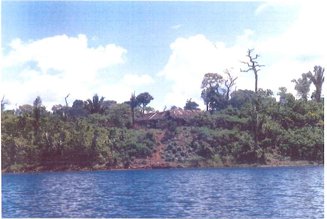
Foto 5 – Habitação muito próxima da margem do reservatório.
