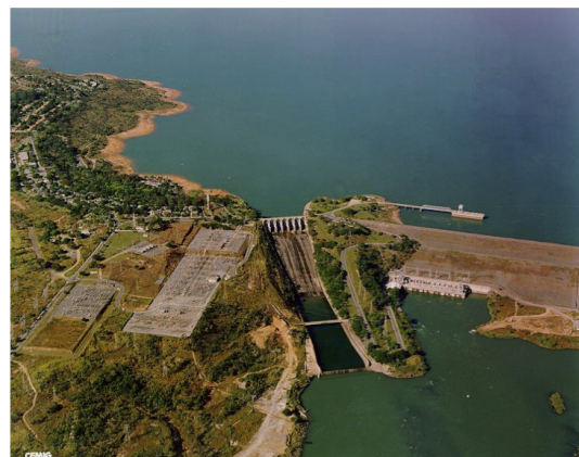
(b) Barragem da UHE Três Marias
