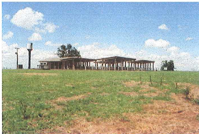
FIGURA 33- Free Stall – instalação livre de paredes. Sistema de ordenha informatizado.
