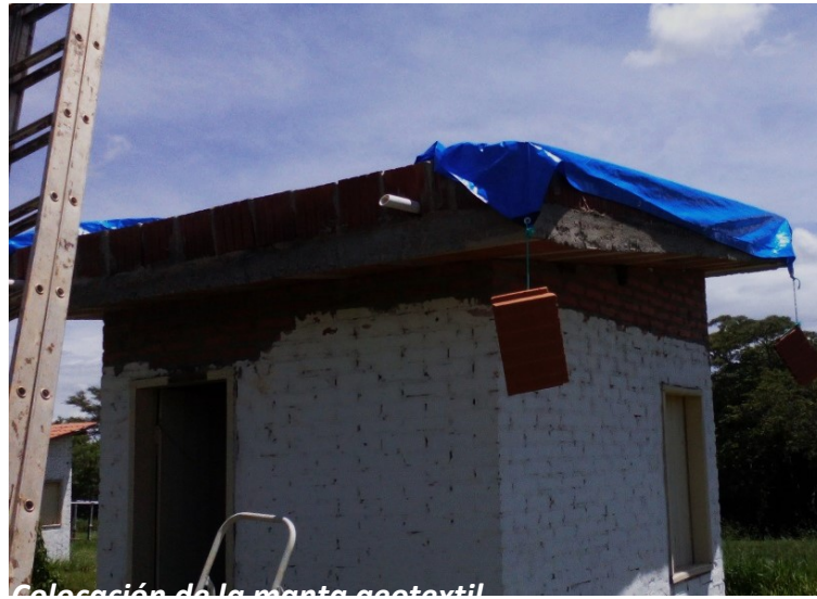
Colocación de la manta geotextil
