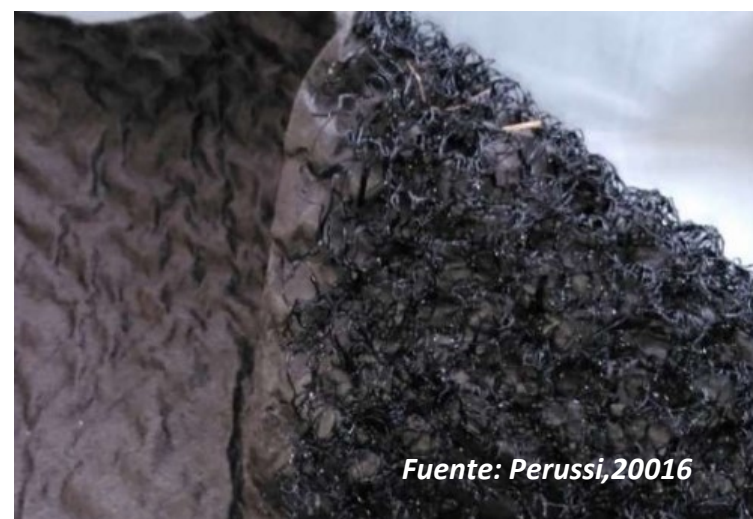
Detalle instalación manta geo geotextil
