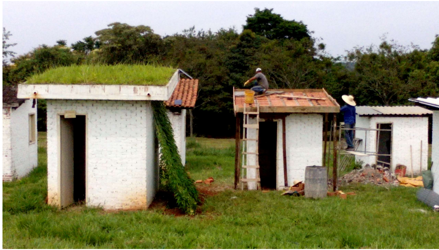
Figura 17. Construcción de tejados verdes
