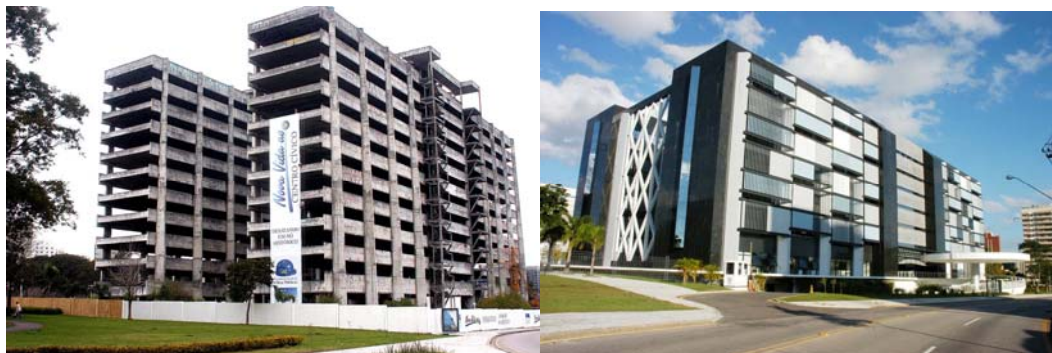
Fig. 74 – Estrutura de concreto abandonada (esquerda) e atual Palácio das Araucárias (direita). Fonte: PARANÁ (2007).
