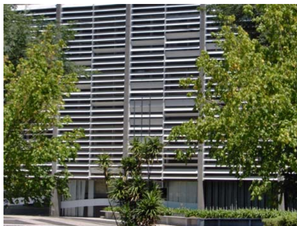
Fig. 68 – Prédio do Detran-PR, Curitiba.
