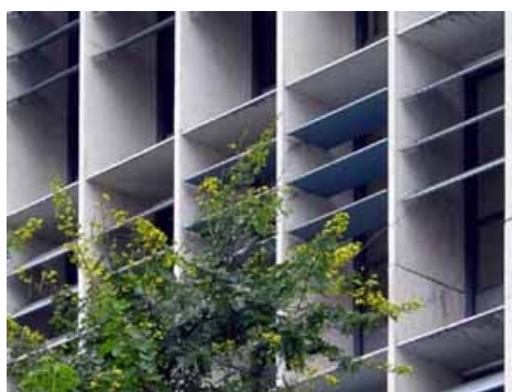
Fig. 37 – Vista externa dos brises empregados no edifício do Ministério da Educação e da Saúde, Rio de Janeiro. Fonte: MELENDO (2004).
