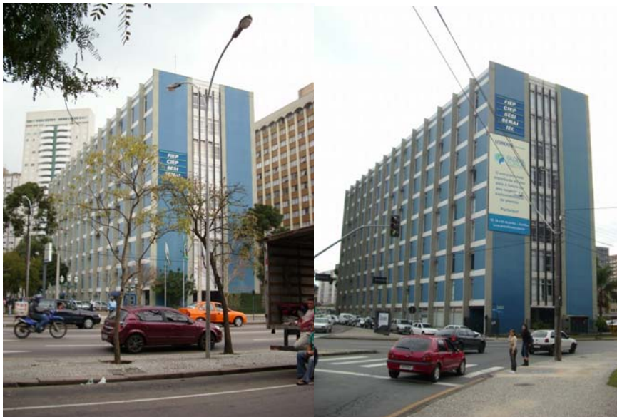
Fig. 110 – Edifício sede da FIEP, fachada nordeste (esquerda) e fachada sudoeste (direita).
