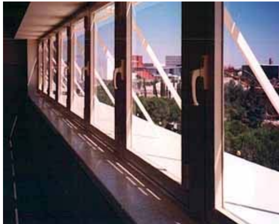
Fig. 58 – Prateleiras de luz na Nova Escola de Engenheiros Industriais, em Sevilha. Fonte: MELENDO (2004).
