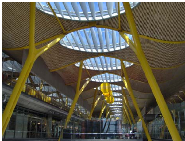
Fig. 55 – Protetores solares móveis, aeroporto de Madri – Barajas, Espanha, Projeto do arquiteto Richard Rogers.
