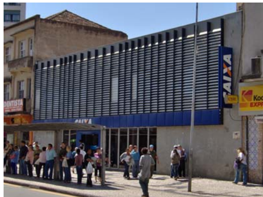
Fig. 49 – Exemplo de fachada com protetor solar horizontal, Agência da Caixa Econômica Federal em Curitiba – Pr.
