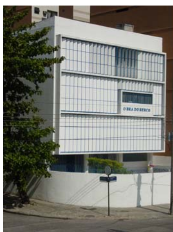
Fig. 39 – Brise-soleil utilizado na Obra do Berço, Oscar Niemeyer, Rio de Janeiro. Fonte: MELENDO (2004).
