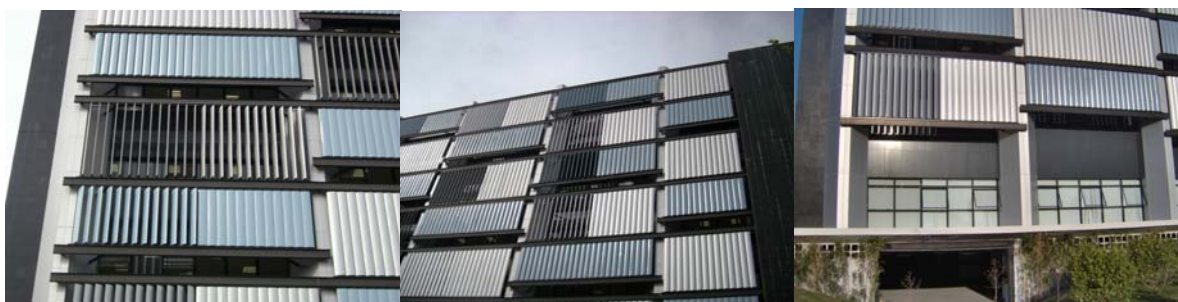
Fig. 76 – Palácio das Araucárias, detalhes dos protetores móveis. Fonte: Arquivo do autor (2007).
