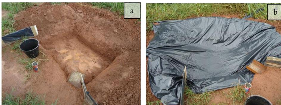
Figura 26 – (a) Escavação da bacia de acumulação e (b) recolocação do encerado plástico
