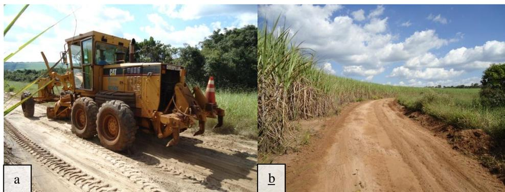
Figura 28 – (a) Motoniveladora em ação; (b) carregador após as duas passagens da Motoniveladora
