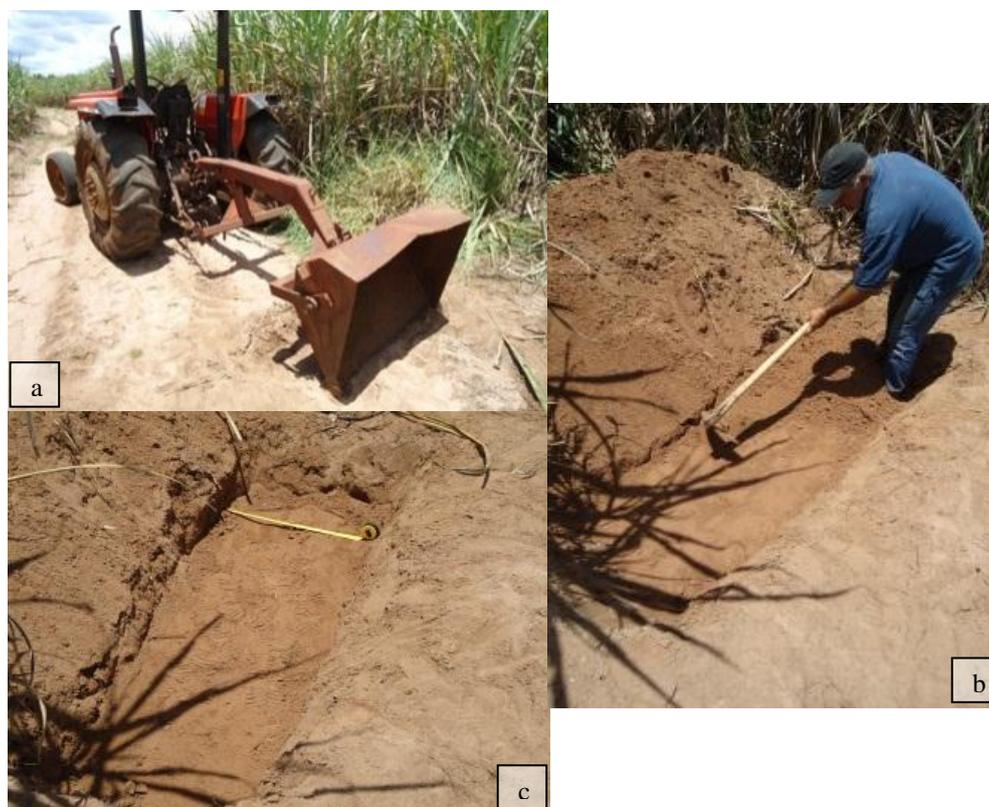
Figura 21 – Escavação de uma das bacias de acumulação, (a) mecânica e (b) manualmente.
