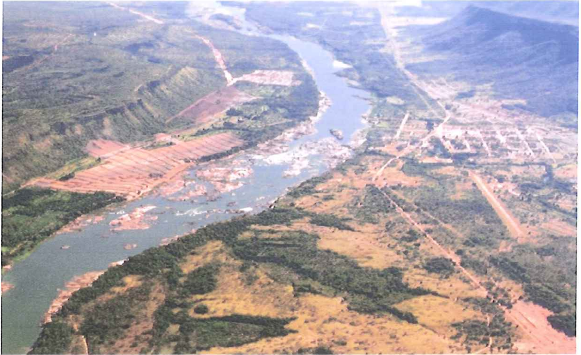
Anexo 24 Início do desmatamento na região onde foi construída a UHE Luis Eduardo Magalhães – TO.
