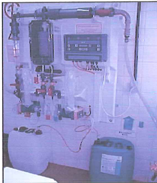
Figura 16 – Gerador de dióxido de cloro modelo Bello Zon® CDVa (CARVALHO, 2003).
