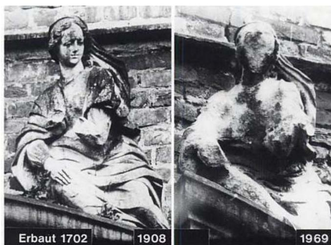
Figura 3.4. Deterioração acelerada em estátua localizada na Alemanha (Winkler, 1994).
