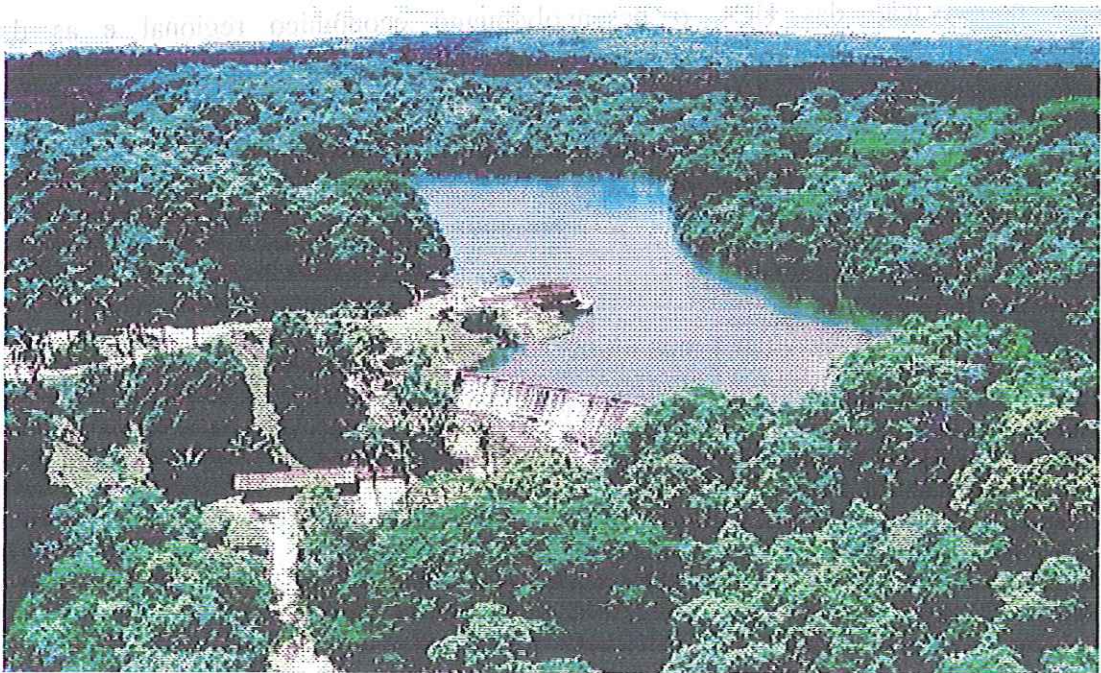
FIGURA 1.2 - Reservatório Cachoeira N.S. das Graças.
