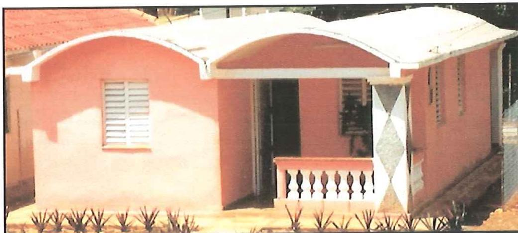
Figura 23: Moradia 10, térrea em detalhe a fachada principal e sistema de cobertura (abóbada) de tijolo. Foto: Adeildo Cabral da Silva
