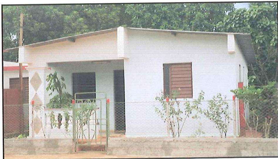
Figura 32: Moradia 14, térrea, fachada principal e em detalhe e sistema de cobertura com telhas de metal (aço galvanizado)
