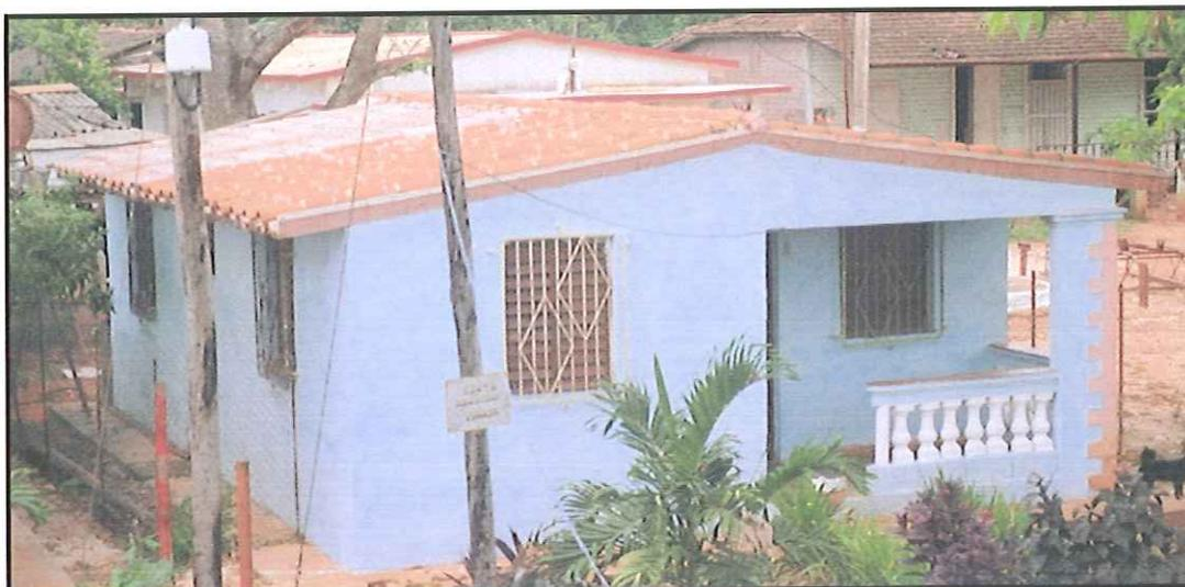
Figura 18: Moradia 7, térrea. Detalhe da fachada principal com grades de proteção e sistema de cobertura Batea. Foto: Adeildo Cabral da Silva
