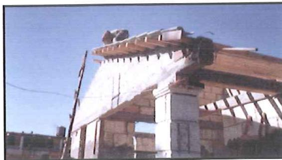
Figura 27: Casa 11 bloco 2, em detalhe, no momento de colocação das telhas sobre a estrutura (TEVI) Foto: CTDMC (2001)
