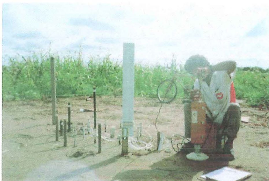
FIGURA 15 – Detalhe da instrumentação instalada nas estações principais E1, E2 e E3
