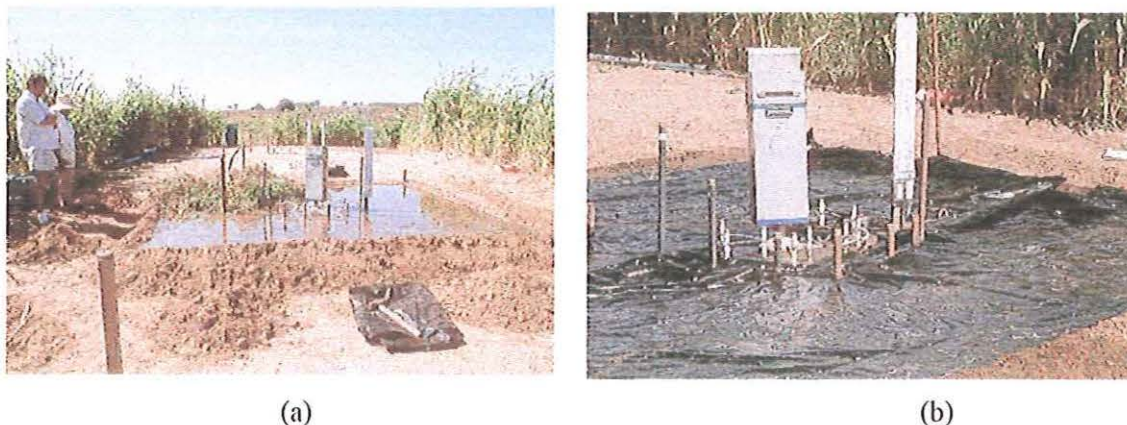
FIGURA 25 – Vista da parcela experimental onde foi realizado o ensaio de drenagem interna
