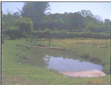
Foto 49 Localização: Área Rural/Urba Coordenadas: 203140.86 / 7565897.68 Descrição: Caixa de areia
