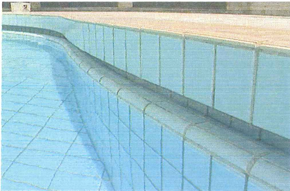
Figura 3-5 Quebra-ondas construído na Associação/clube 2 – AC3.
