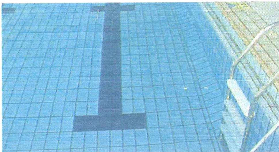
Figura 3-6 Sinalização do fundo da ACa5.
