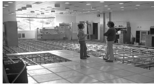
Figura 6 - Imagem de plenum em construção. Fonte: www.honeysuclecreekstation.net .
