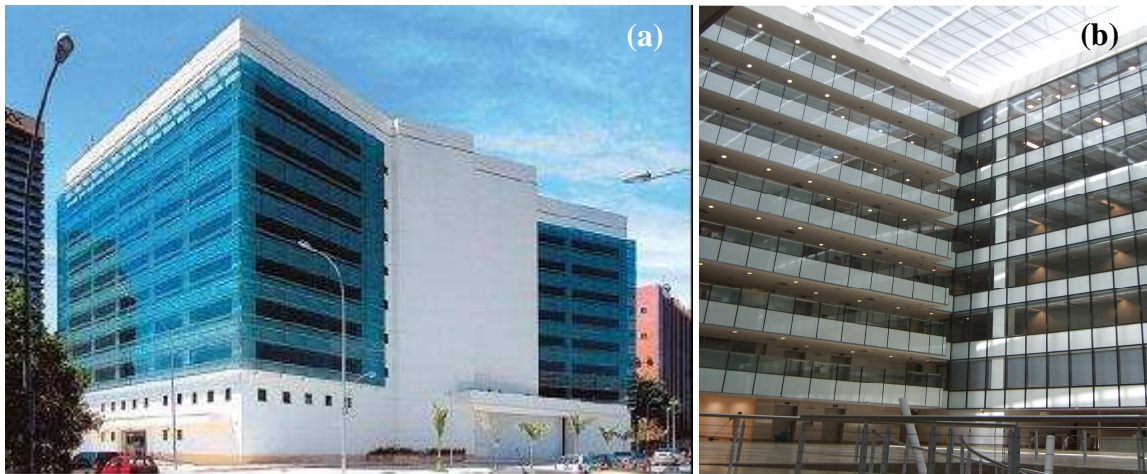
Figura 7 - Imagem da fachada externa (a) e do átrio central (b) do Edifício Bracor.
