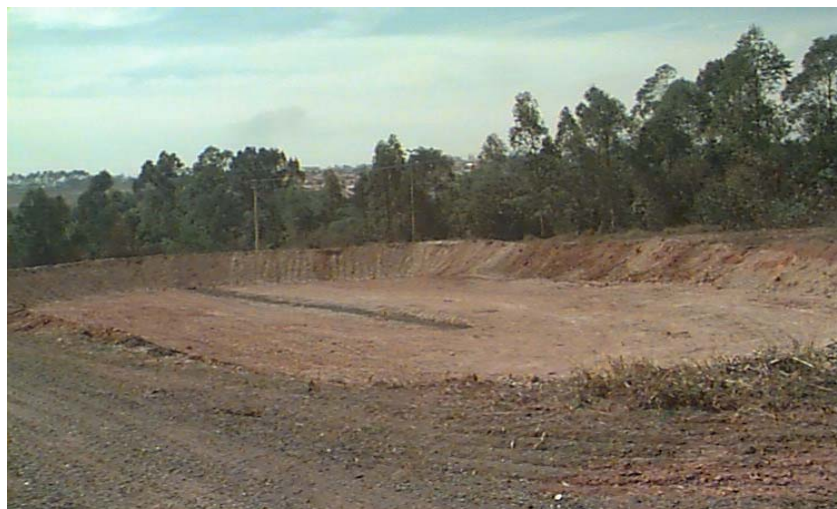
FIGURA 5.16 – Vala para armazenamento/secagem de lodo, construída na ETE - Jardim das Flores para disposição emergencial de lodo digerido proveniente do UASB.
