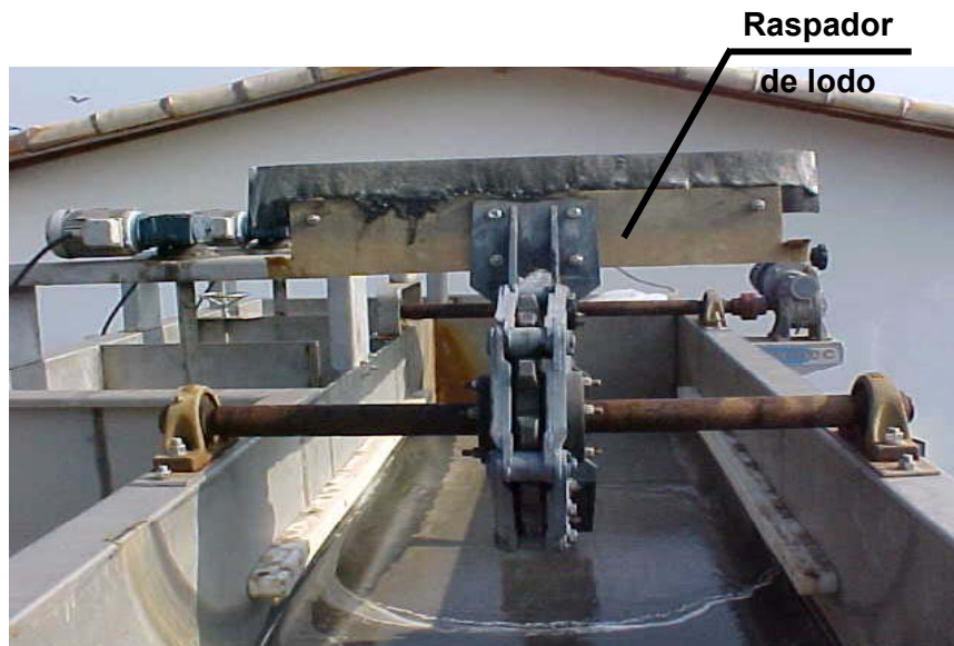
FIGURA 4.16 – Raspador mecânico de superfície para remoção do lodo acumulado durante a flotação.
