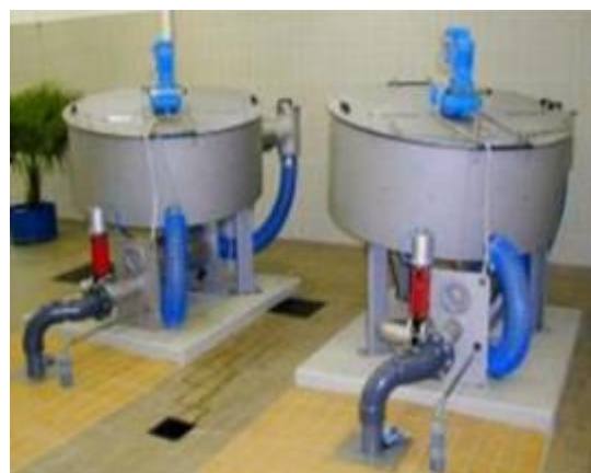
(b) Adensador de Disco
