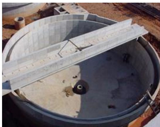
(a) Adensamento por Gravidade
