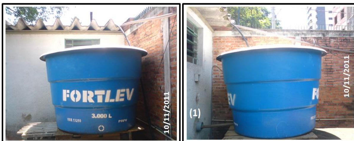
Figura 9 - Reservatório de armazenamento do lixiviado coletado: (1) tubulação para coleta de lixiviado na parte interna da planta experimental. Foto da autora.
