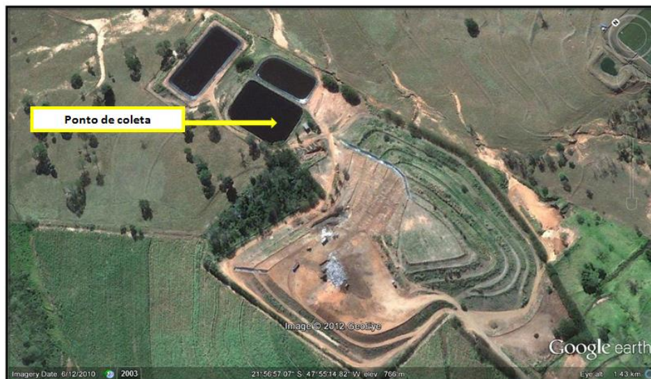
Figura 8 - Vista aérea do aterro sanitário de São Carlos-SP, com indicação do ponto de coleta do lixiviado. Fonte: Google Earth.
