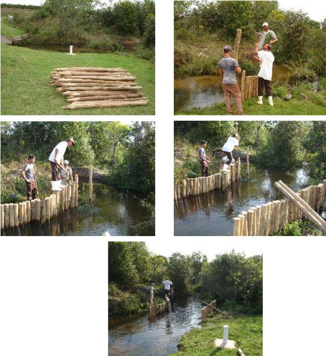
Figura 33. Cravação das toras de eucalipto para estabilização da seção fluviométrica
