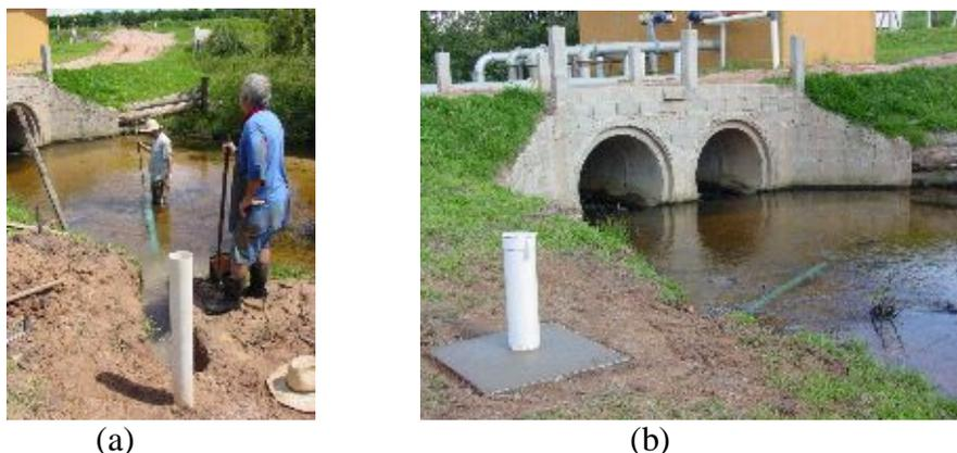
Figura 45. (a) Linígrafo em fase de implantação e (b) Linígrafo instalado
