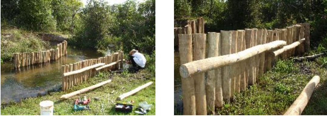
Figura 34. Instalação das toras transversais
