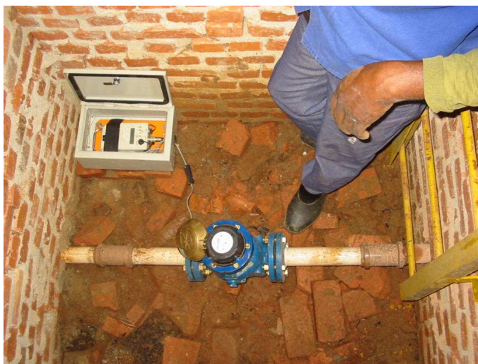
Figura 4.4 – descarga D22 (Sol Nascente) com medidor e coletor de dados
