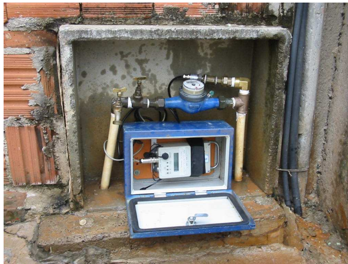
Figura 5.1 – instalação típica de sensor de pressão
