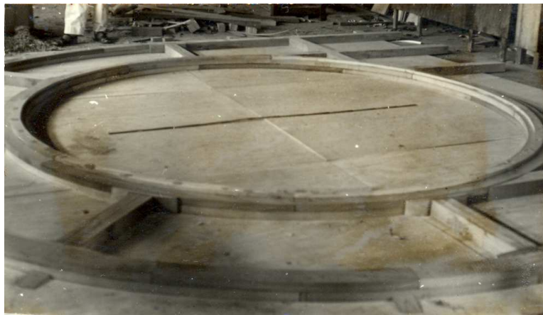
Figura 4.11: Montagem do diafragma e sua armação estrutural
