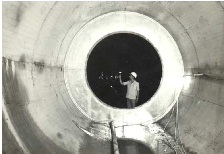
Figura 5.5: Diafragma instalado no desemboque do Túnel 2 - Segundo Ensaio
