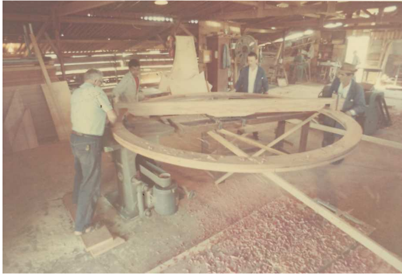
Figura 4.10: Execução do diafragma
