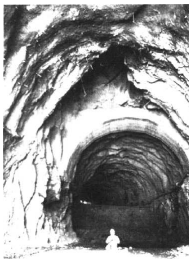
Figura 4.21: Exemplo de sobreescavação
